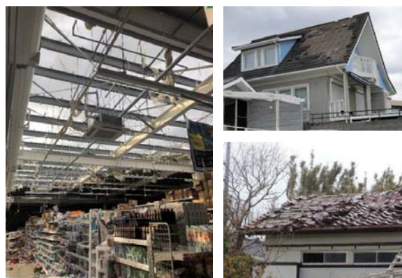
平成30年台風第21号と令和元年台風第15号の強風による屋根ふき材の被害例
