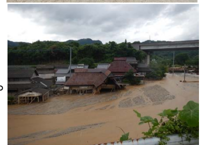
土砂・洪水氾濫による被害の例
