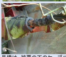
吊橋は、被覆の下のケーブルの状態把握が期待される
