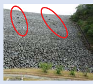
フィルダム堤体上での変位計測(測量用標点)
