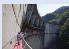
目視による外観点検
