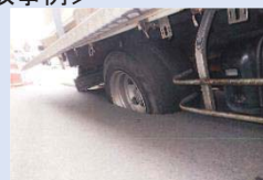
下水道管の破損による道路の陥没
