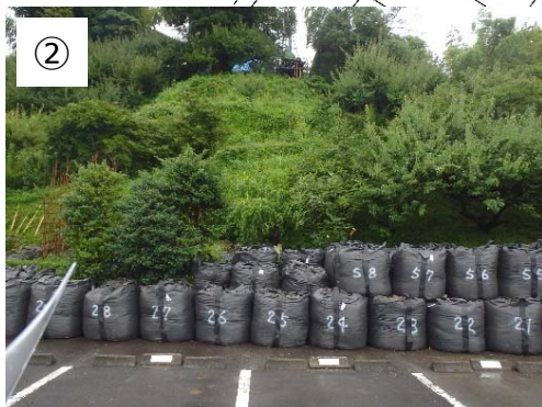
大型土のう設置状況
