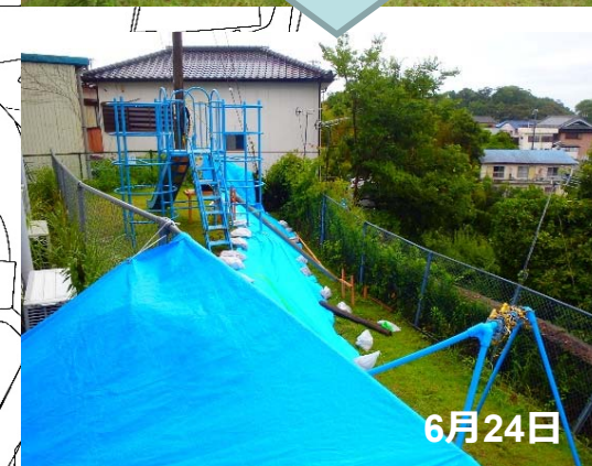
頭部の亀裂の変状状況
