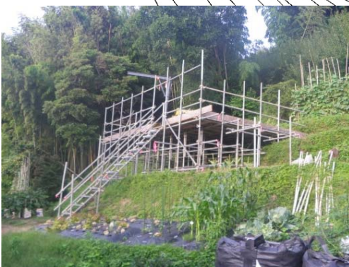
排水ボーリング施工状況
