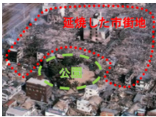
火災の延焼を防止した公園 (阪神・淡路大震災、神戸市)
