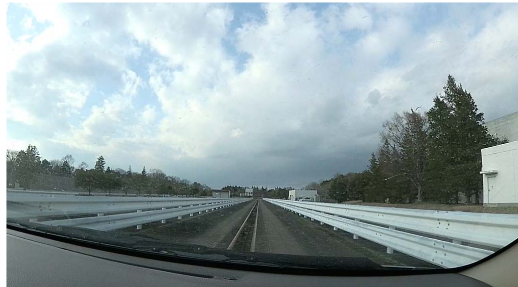
④加速路(所定の速度まで実験車両を加速)
