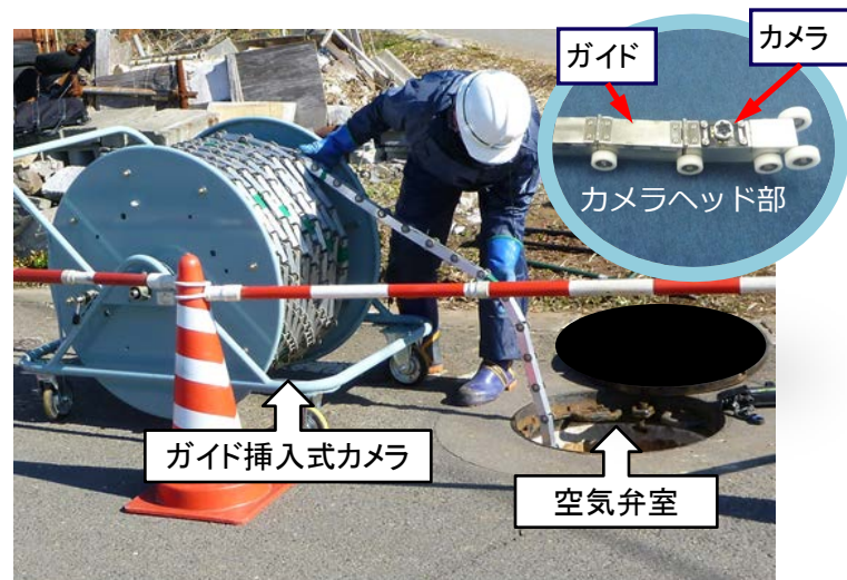
図-2 ガイド挿入式カメラを使った調査風景
