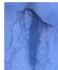
外装材のはがれ (多数回の改修歴がある場合)
