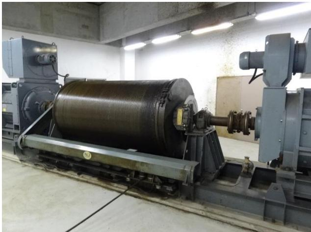
写真-1 巻取電動機とドラム
