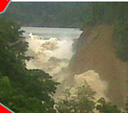
天然ダムの決壊状況
