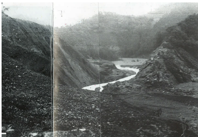
決壊後の花園村金剛寺天然ダム (昭和28年10月2日撮影)
