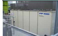
都市ガス併用で消化ガス100%利用可能で発電効率は40%以上
