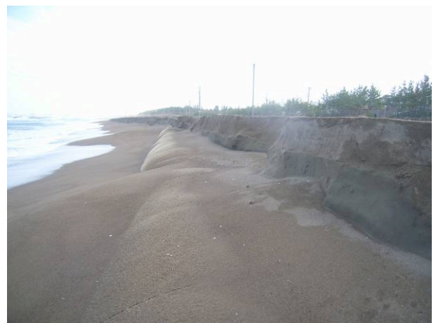
写真 2 現地の砂浜に馴染んだ色のサンドバック（S P）
