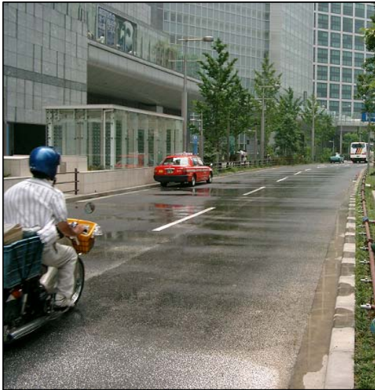
図-1 再生水が散水された路面の様子 （東京都汐留土地地区画整理事業地区）
