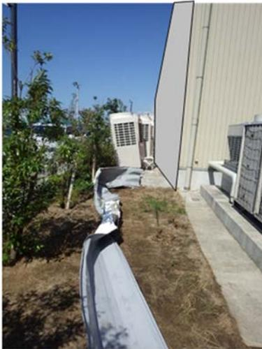
写真 4.10 鋼板製屋根材の脱落
