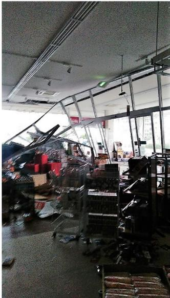
写真 4.40 建具の脱落・転倒とカート等の移動
