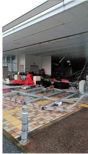
写真 4.37 南西に面する建具の脱落・
