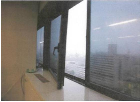
写真 3.13 15 階窓枠の外れ（当該庁舎提供）
