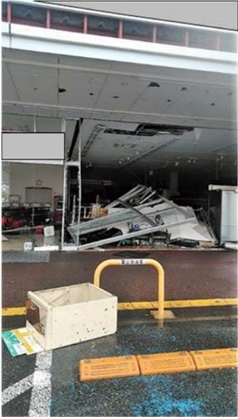
写真 4.36 南東に面する建具の脱落・
