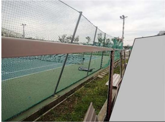
写真 4.33 フェンスを構成する板材の脱落
