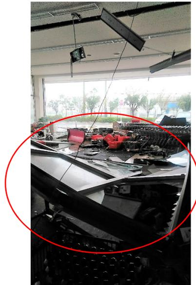
写真 4.41 入口内側にある建具の脱落・転倒
