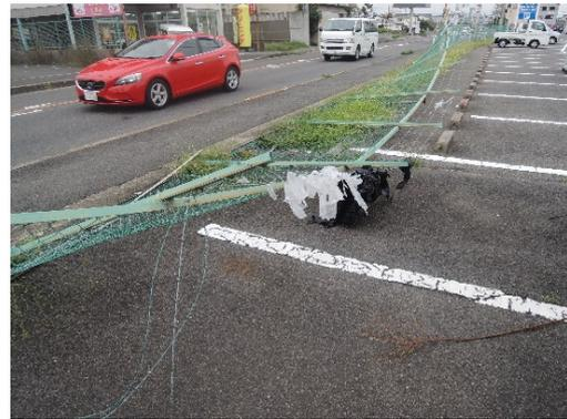
写真 4.49 フェンスの著しい変形
