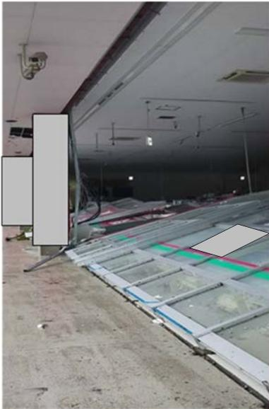
写真 4.2 屋外に面する建具の被害直後の状況
