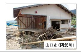
家屋構造そのものが破壊されているのは、河川付近にあった家屋のみで、その大半は基礎下部が氾濫流により洗掘を受け、土砂流出により家屋が傾く被害であった。
