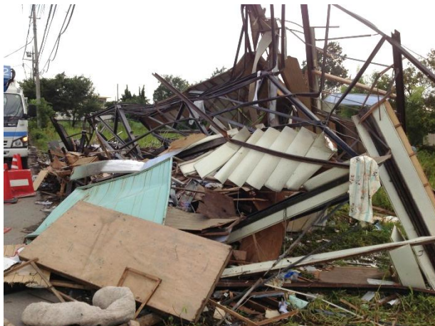
写真3 飛散した上部構造
