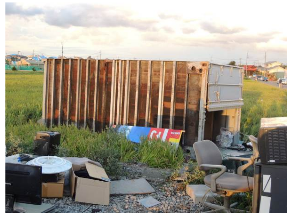
写真 4. 4. 2 転倒した鋼製コンテナ（2）
