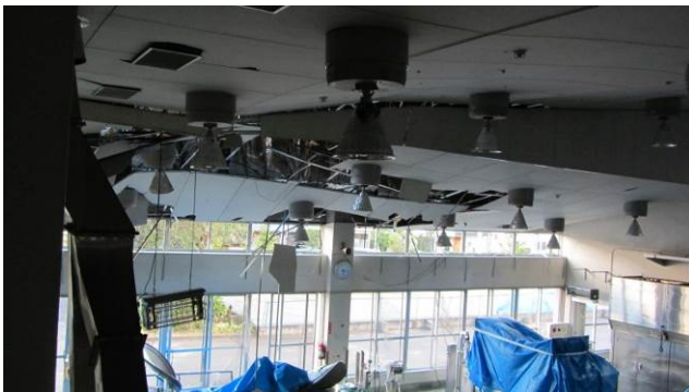
写真 4. 1. 28 天井の破壊
