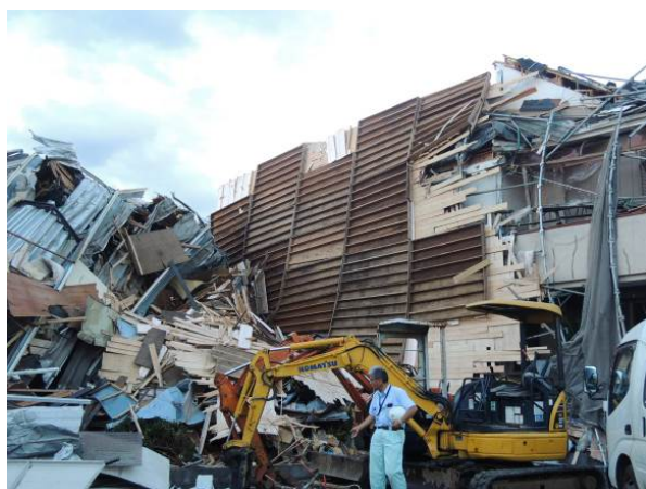
写真 4.2.3 上部構造の飛散
