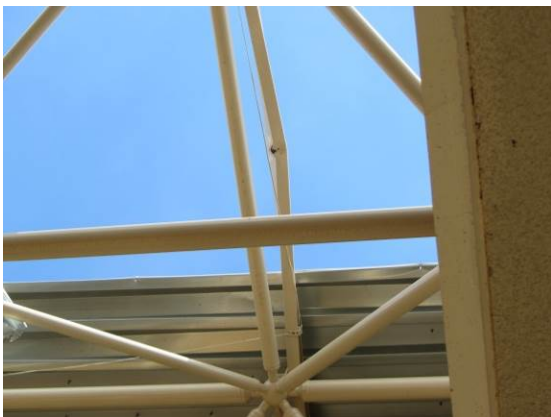
写真 4. 1. 7 母屋の変形
