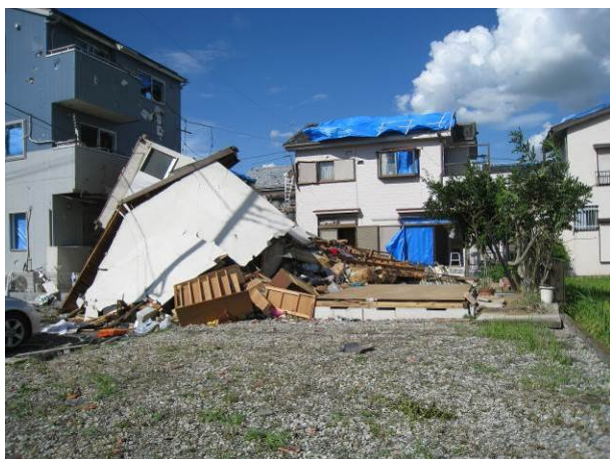
写真 4.2.1 上部構造の倒壊（1）
