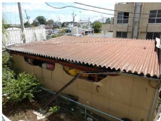
写真 4.1.24 建築物背後の倉庫
