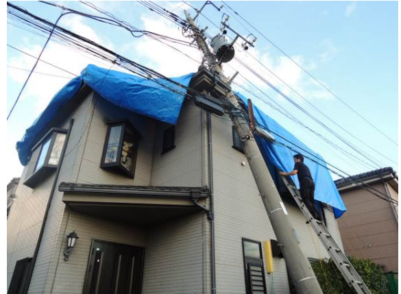
写真 4. 4. 4 電柱の折損（隣家に衝突している）
