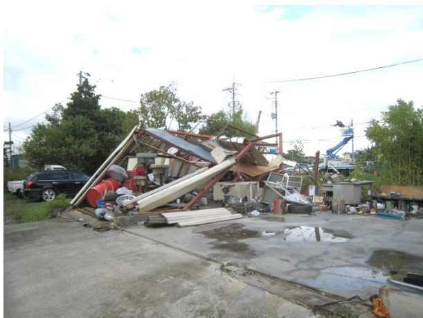
写真2 軽量鉄骨造住家兼作業場跡
