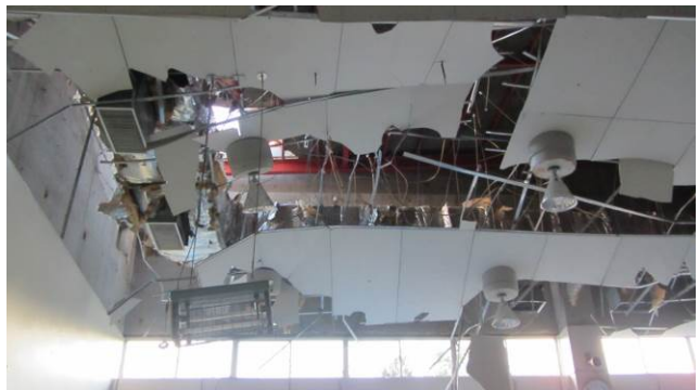
写真 4. 1. 28 天井の破壊
