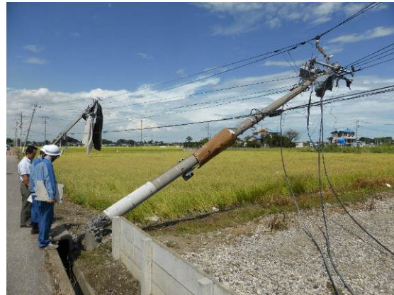
写真 4. 1. 10 電柱の倒壊
