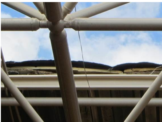
写真 4. 1. 5 屋根ふき材の断面
