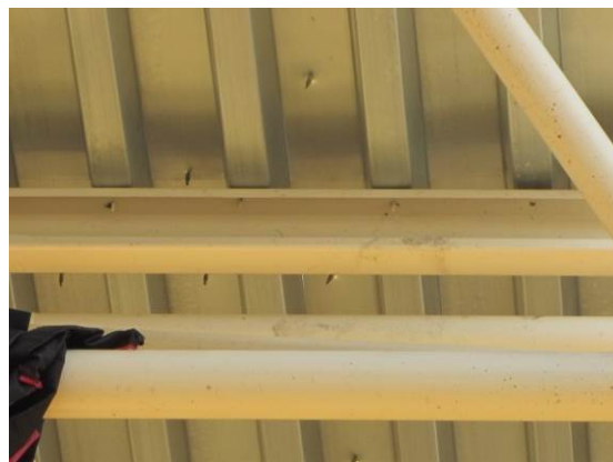
写真 4. 1. 6 屋根ふき材と母屋との接合部（ビス）
