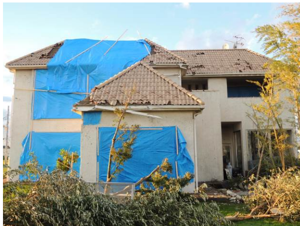
写真 4.2.13 屋根及び開口部の応急措置の状況
