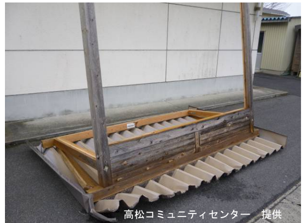
写真 9 木製小屋の倒壊
