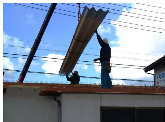
写真 11 屋根の修復状況
