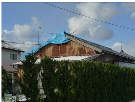
写真 19 住家のけらば部の損傷
