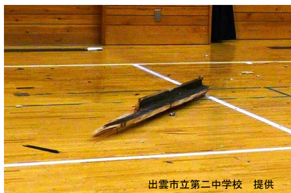
写真2 屋根を貫通した角材
