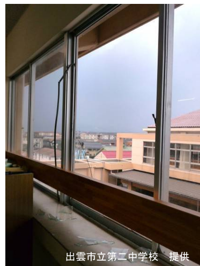
(c) 屋外に面した窓ガラス
