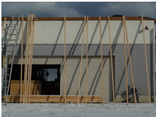
写真 16 開口部の状況 立てかけてあるのは垂木に用いる材
