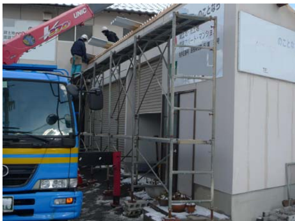
写真 12 開口部の状況
