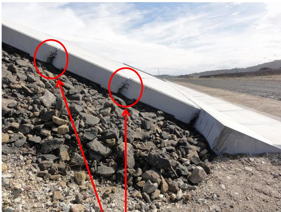
下のブロックが上のブロックより飛び出ないように、かみ合わせ構造とした
