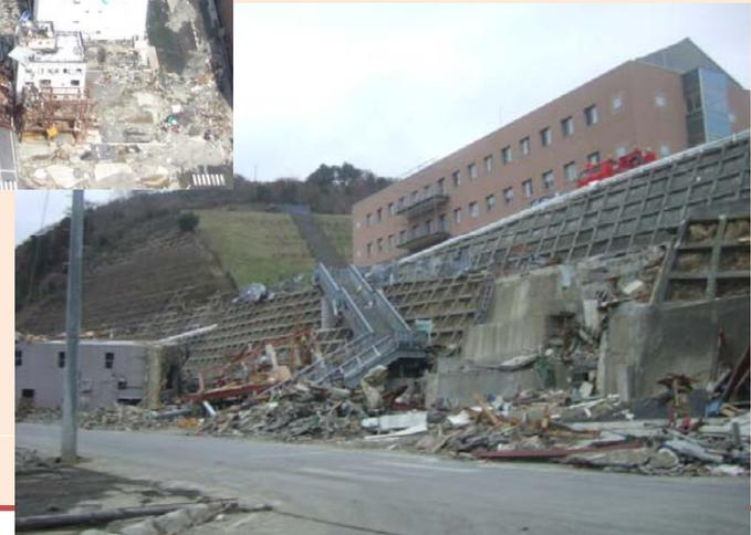
写真 16. 津波避難用鋼製階段<sup>1</sup>
