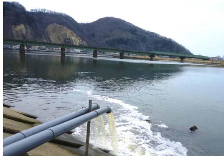
汚水ポンプ場(停止中)付近で簡易沈殿処理、消毒後、本川まで導水して放流(旧北上川)
