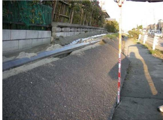
写真-5 潮来市の液状化による管きょ被害
