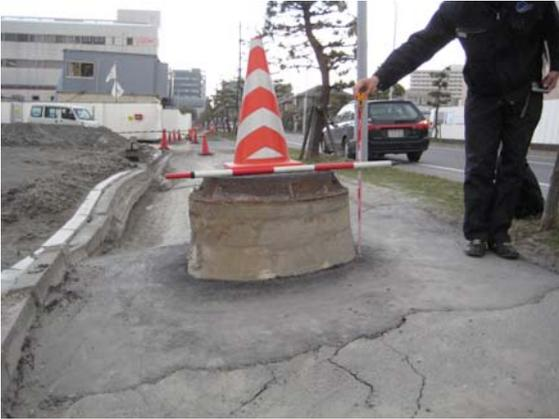
写真-4 浦安市の液状化による管きょ被害
