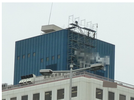
写真 74 ペントハウスの傾斜
