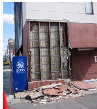
写真 60 帳壁の脱落 2
