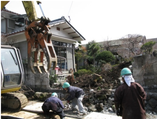
写真5 被災したブロック塀（解体中）
