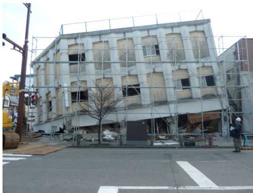
写真 37 1 階の層崩壊
