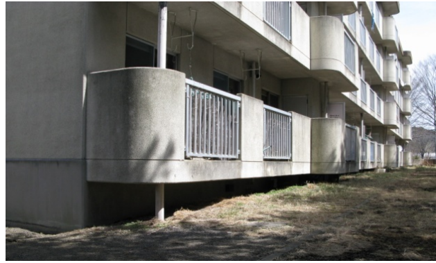
写真 10 a 棟外観（沈み込みの小さい妻面側から見る）
