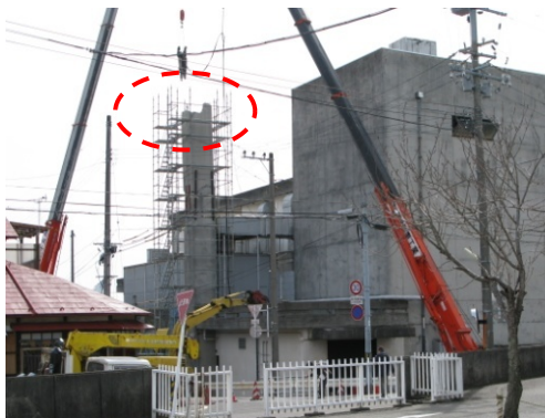
写真1 亀裂の入った煙突の上部を解体中
