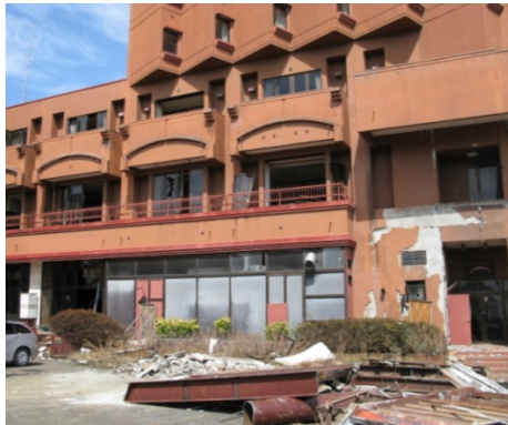
写真 15 RC 造（一部 SRC）の棟
