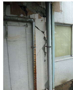
写真 112 曲げ破壊
