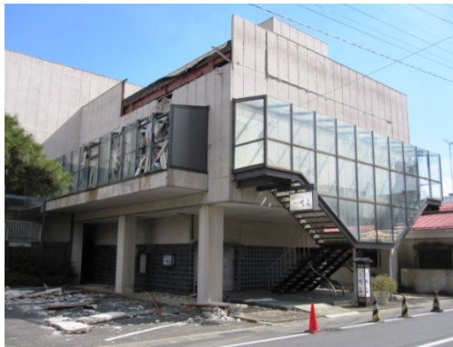
写真 59 帳壁の脱落 1
