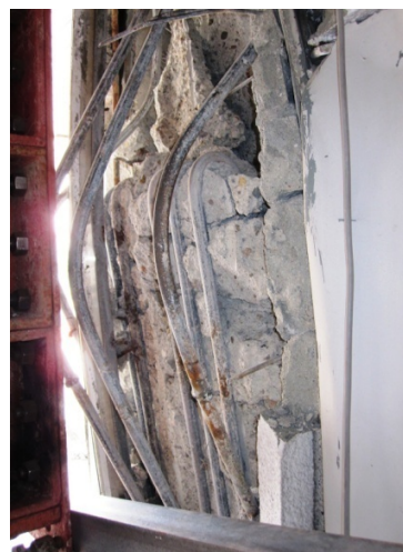
写真 47 柱段落とし部詳細
