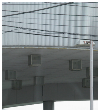
写真 136 無被害の類似天井
