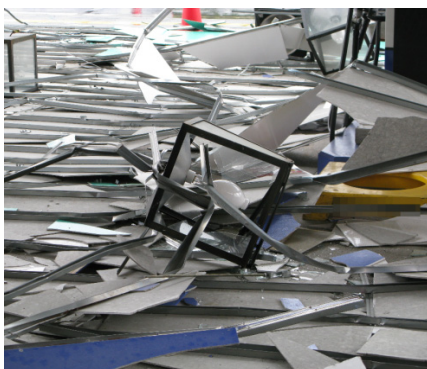
写真 135 天井が全面落下したガソリンスタンド
