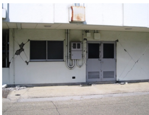
写真 50 袖壁付き短柱のせん断破壊 および非構造壁のせん断ひび割れ
