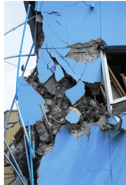
写真 114 2階柱の破壊
