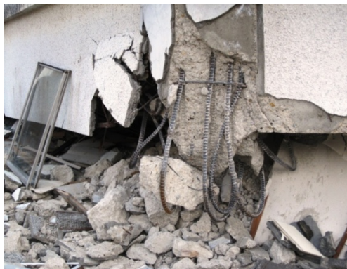
写真 38 隅柱の崩壊
