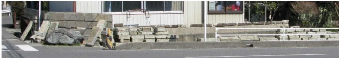
写真 25 石塀の倒壊
