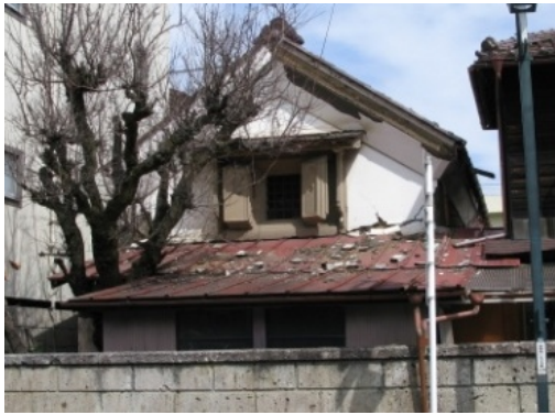
写真3 土蔵の被害
