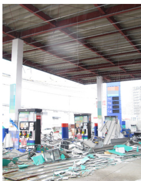
写真 135 天井が全面落下したガソリンスタンド
