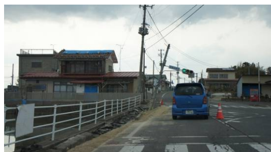
写真 71 傾倒した信号機
