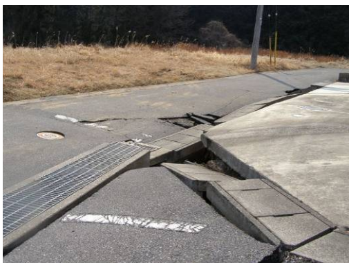
写真 37 路盤の陥没
