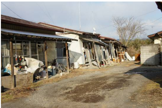
写真 23 地盤変状に伴う木造借家の被害 （塩阿久津上地区）
