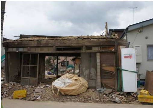
写真 67 解体撤去作業中の被災建築物
