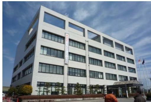
写真 2 那須町役場庁舎
