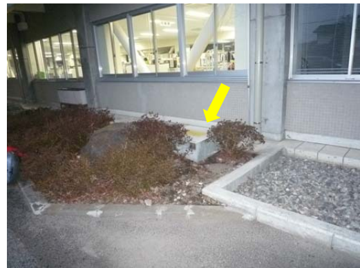
写真 75 さくら市役所震度計設置状況
