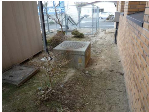
写真 73 震度計設置状況
