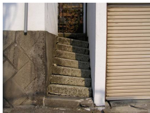
写真 40 階段の傾斜
