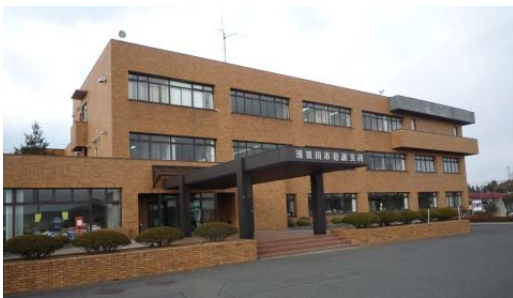
写真 70 須賀川市岩瀬支所
