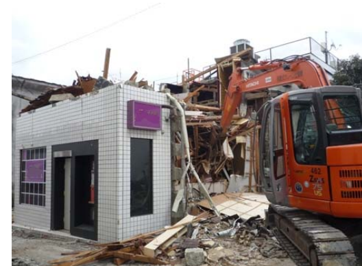
写真 56 写真 55 の解体撤去作業
