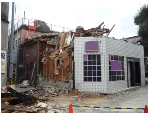
写真 55 大被害と推測される木造
