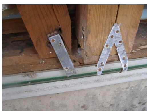
写真 14 写真 13 の柱脚及び筋かい端部
