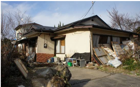
写真 21 地盤変状に伴う住宅被害 （西大久保地区）
