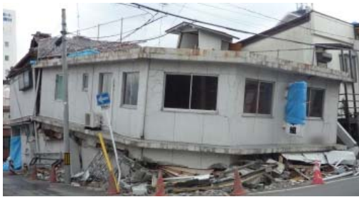
写真 51 コンクリートブロック造と見られる建築物の倒壊
