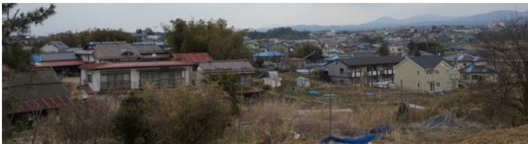
写真 68 南町から東側一帯の風景（ブルーシートをかぶせた屋根が多い）
