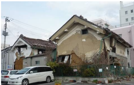
写真 53 大きく損壊して残留変形がある土蔵
