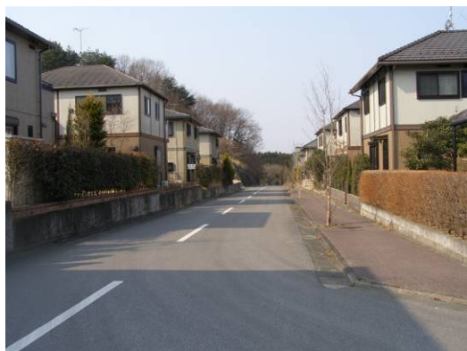
写真 33 ロビンシティー地区の無被害住宅
