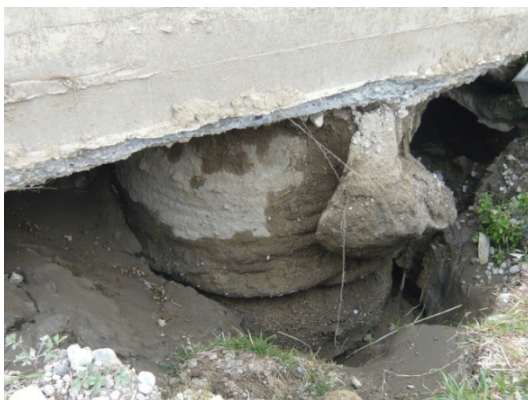
写真 2 2 † 杭頭部の露出状況
