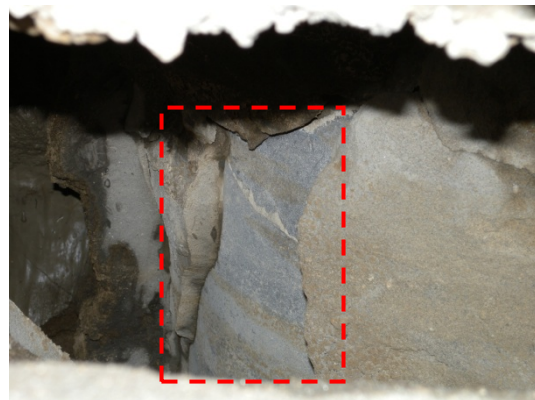
写真 2 3 † 杭周固定液の内部
