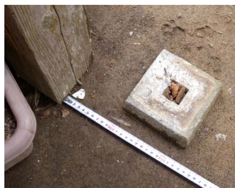
写真10 物置柱脚の移動
