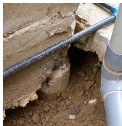
写真 1 2 建物角部の支持構造物
