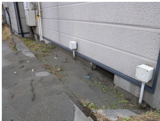
写真31 基礎部分の外観（1）
