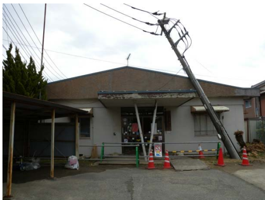
写真3 保健センター入口付近の状況
