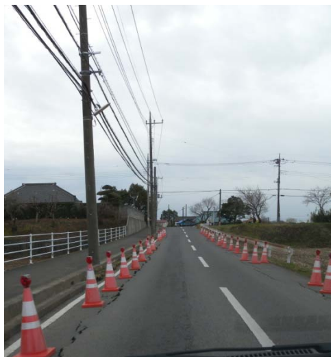
写真2 路盤の亀裂
