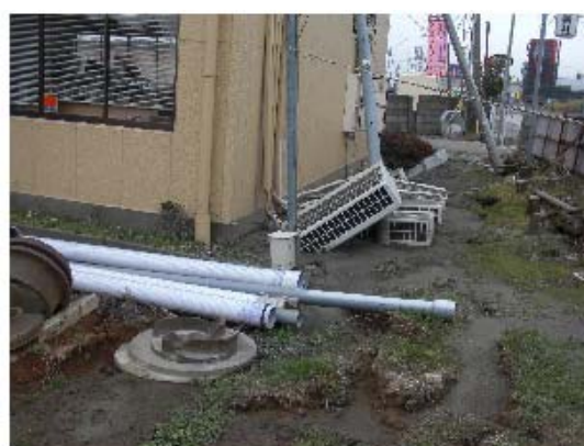
写真 1 6 †) 写真 1 5 の周囲の変状 (右側が県道 11 号)
