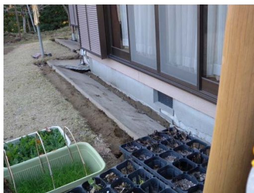
写真 3 8 基礎部分外観
