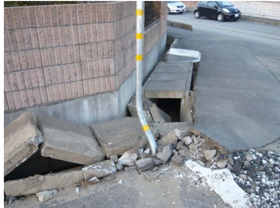
写真 4 0 側溝の被害
