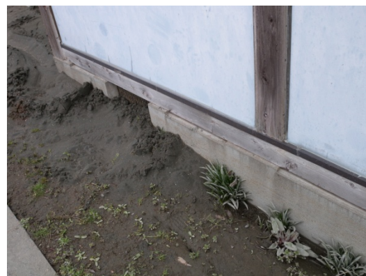
写真32 基礎部分の外観（2）
