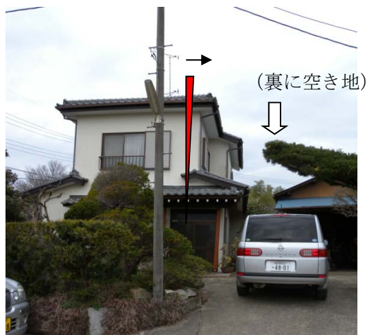
写真7 傾斜 4/100 程度の建築物
