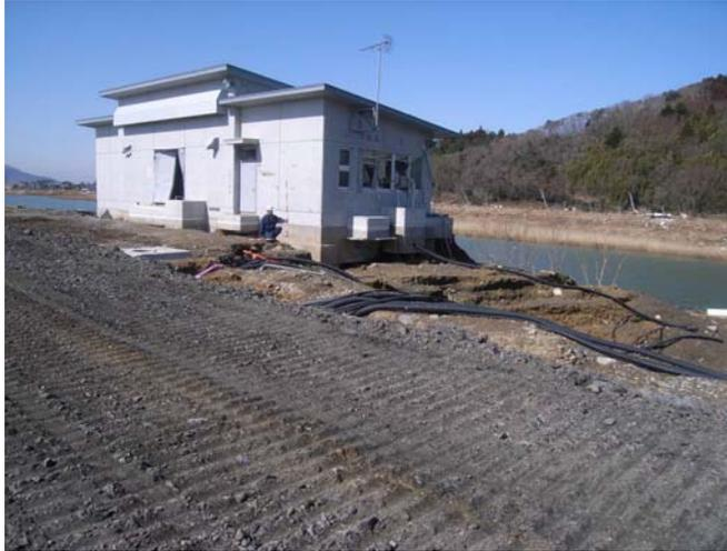
◆堤防天端とほぼ同一の高さに設置された施設：窓の損壊が水位痕跡と推定される（天端から1.5~2mの高さ）
