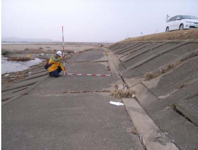
◆水門脇の護岸の陥没：地震動に起因するものと推察
