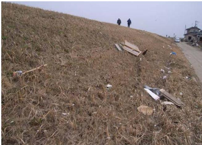
◆堤内側のり面の痕跡水位：川側に比べて水位が低いと想定される
