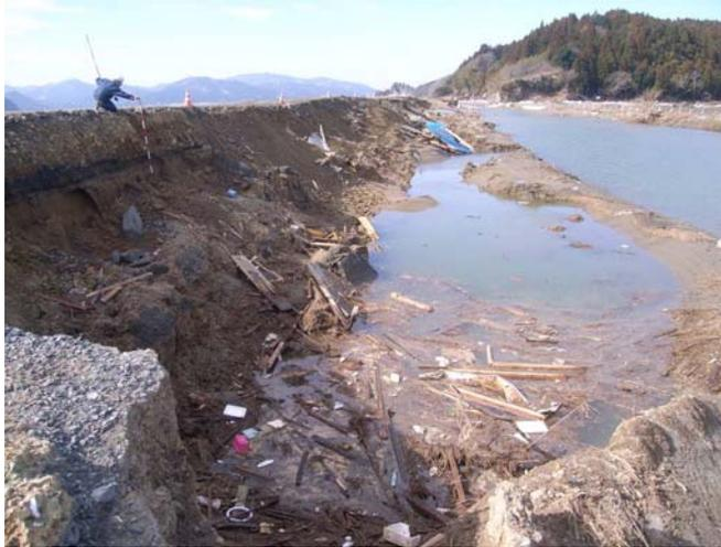
◆堤内側への越流によるのり面の侵食と落ち堀の形成
