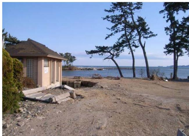
◆堤防天端とほぼ同一の高さに設置された施設：屋根の損壊が水位痕跡と想定される（天端から2m以上の高さ）
