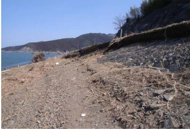
◆山付き部では表土が流失し、岩盤面が露出
