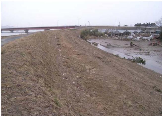
◆堤内側のり面には越水による侵食・植生の倒伏：痕跡水位は小段上程度
