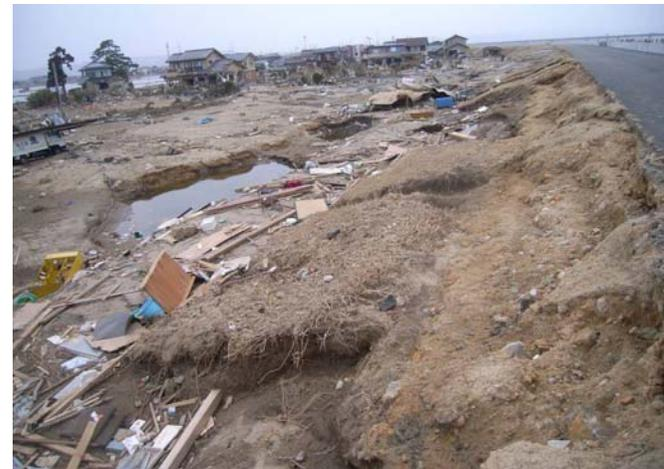
◆津波遡上を遮る形となる堤防区間：パラペットの手すりに流送物が見られる：越水によるのり面の侵食と深い落ち堀の形成
