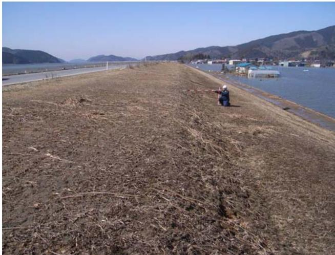
◆堤内側のり面の越流による侵食：植生が法尻に向かって倒れ、溝状の堤体侵食が発生
