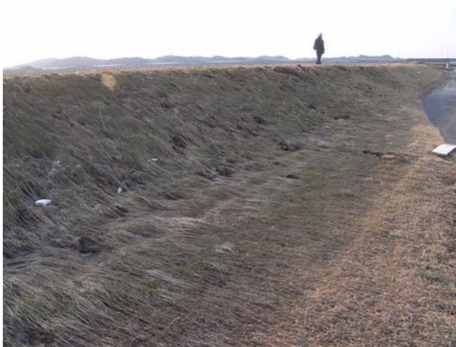
◆堤内側のり面の川側からの越流水を示唆する痕跡
