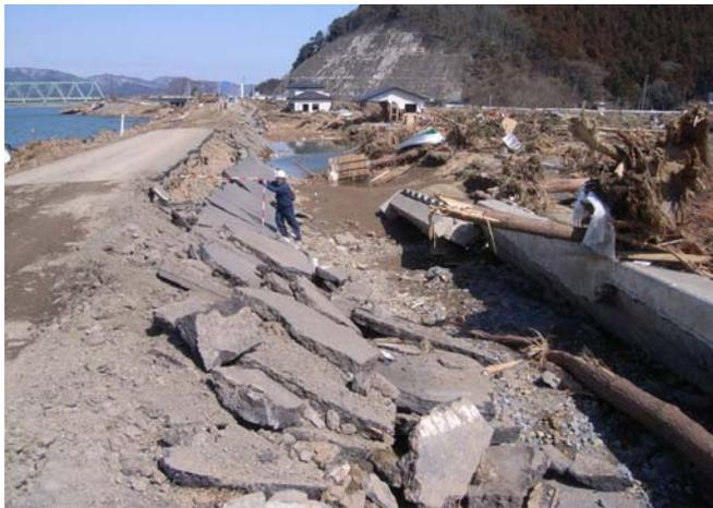
◆堤内側の侵食状況：下流側（写真奥）では落ち堀形成から越水による侵食、上流側（写真手前）は擁壁の存置から天端侵食と推定される
