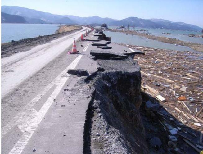
◆堤内側への越流による侵食：天端が一部流失する
