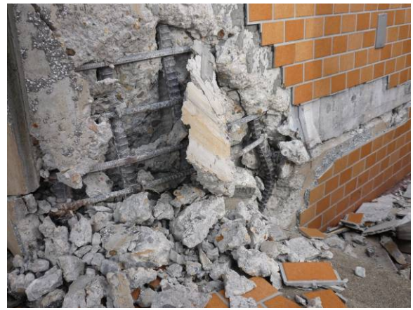
写真 34 1 階柱脚部の破壊状況
