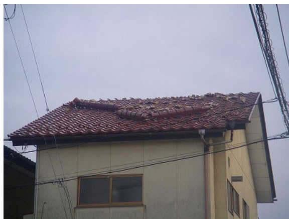
写真 60 棟瓦の脱落
