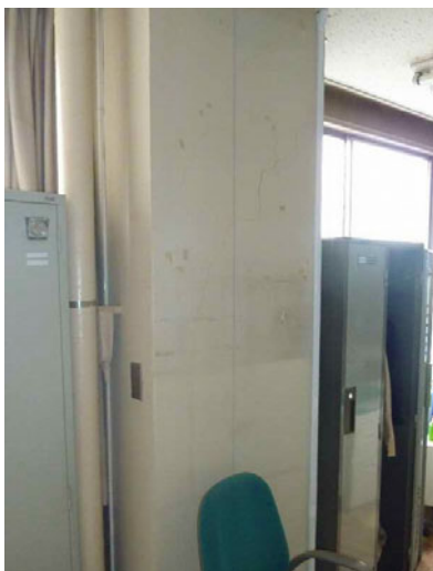
写真 63 柱と方立て壁のせん断ひび割れ
