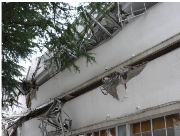
写真 76 2階層崩壊部
