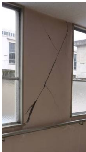
写真 63 柱と方立て壁のせん断ひび割れ
