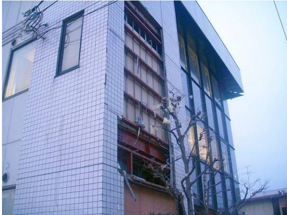
写真 47 事務所ビル D の外観
