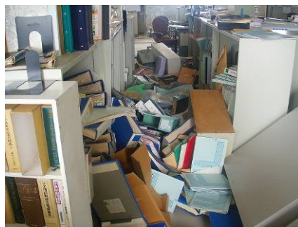
4 階（ロッカーの転倒と書類の散乱）
