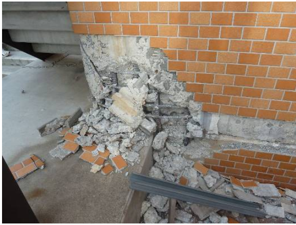
写真 34 1 階柱脚部の破壊状況
