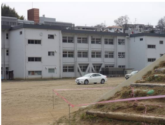
写真 19 C 小学校校舎外観
