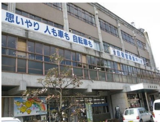
写真 1 三春町役場の外観
