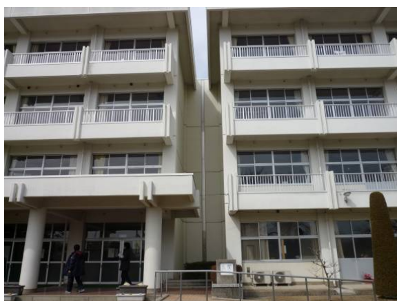
写真 6 A 中学校校舎外観（エキスパンション・ジョイントで隣接する 2 棟）
