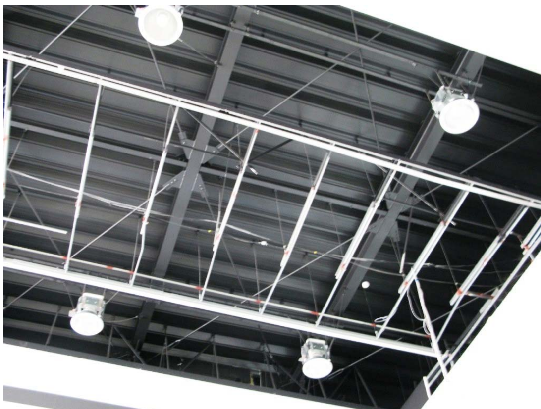
写真5 天井Bの下地 搭乗口側
