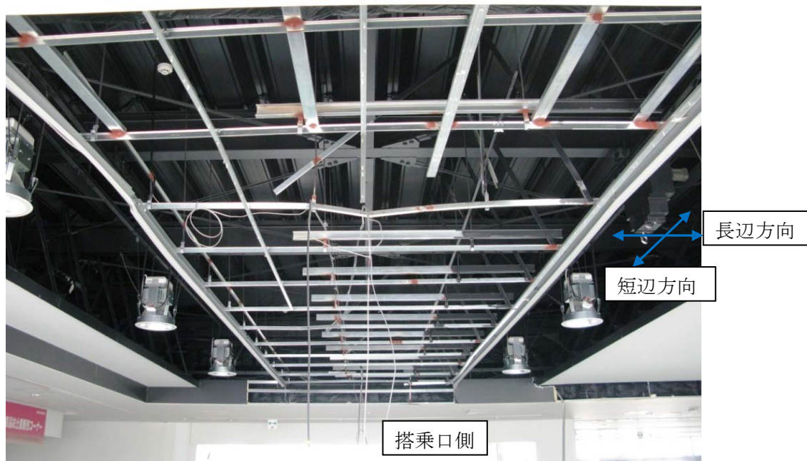
写真 6 天井 B の下地と幕板の破損
