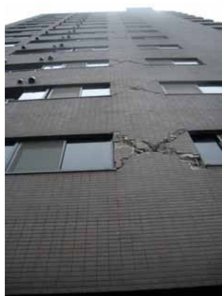
写真 15 共同住宅外壁面のせん断ひび割れ
