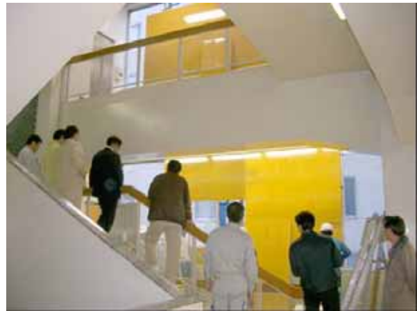
写真 2 破損した窓ガラス
