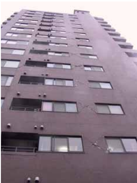
写真 15 共同住宅外壁面のせん断ひび割れ
