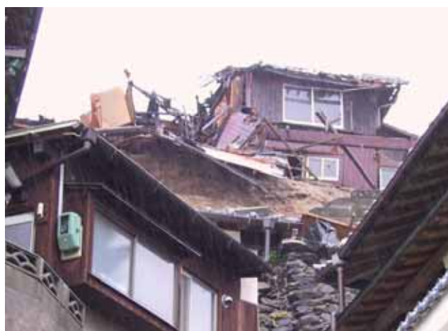
写真 28 敷地と構造の崩壊
