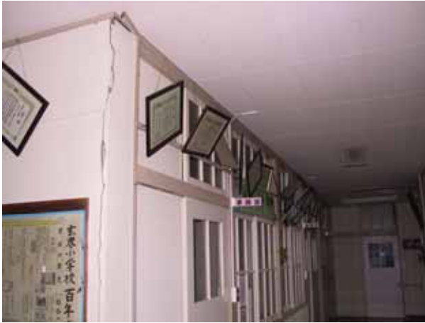
写真 39 小学校の内部
