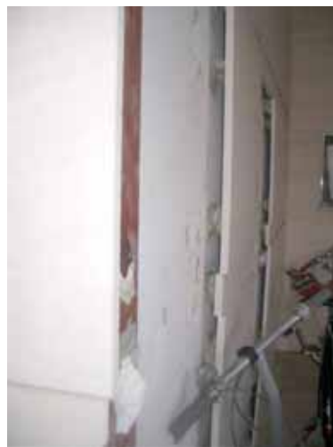
写真 21 外壁の剥離
