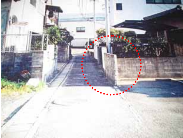
写真 9 倒壊前の状況（平成 11 年頃撮影・福岡市役所提供）
