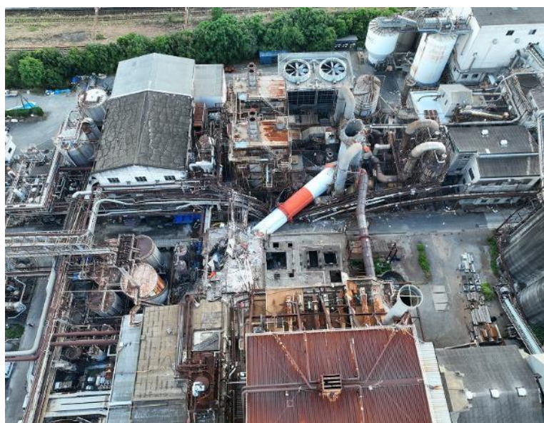
(a) 転倒した煙突周辺の状態
