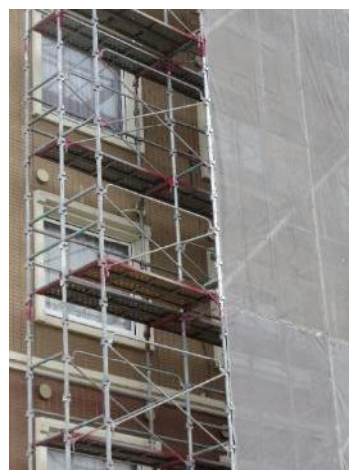
写真 3.2.43-4 非構造壁のせん断ひび割れ
