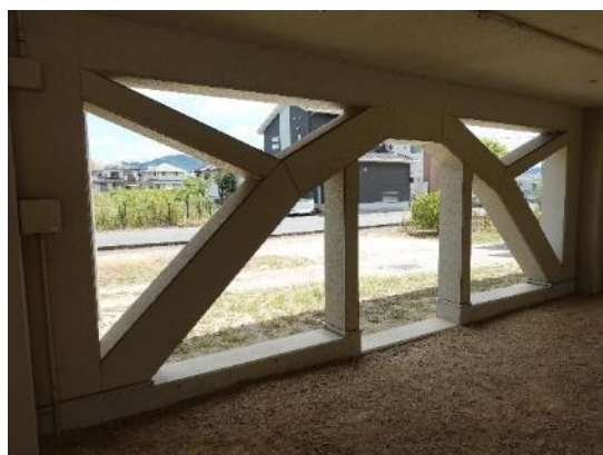
写真 3.3.2-2 補強ブレース
