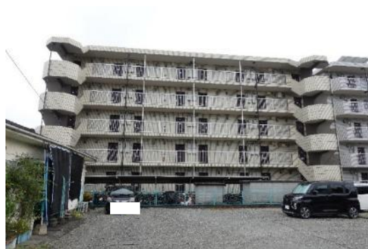
写真 3.2.9-2 周辺にある共同住宅の状況
