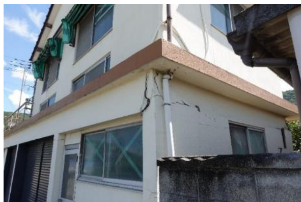
写真 3.4.13-2 外壁の被害
