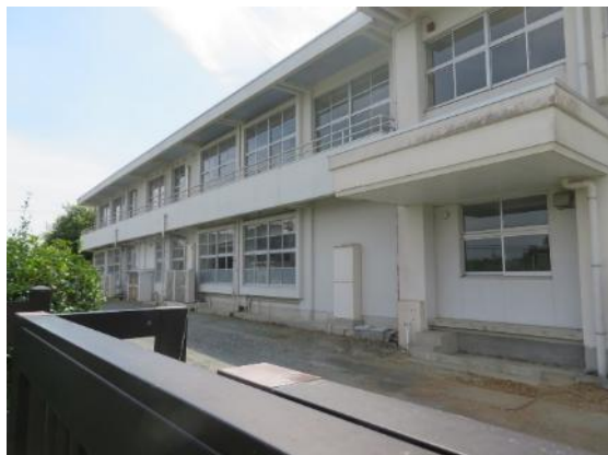
写真 3.4.4-1 建築物外観（UK-4）
