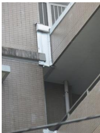
写真 3.2.22-3 Exp.J 部の変形状況
