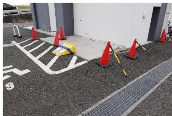
写真 3.2.40-2 建築物周辺地盤の変状
