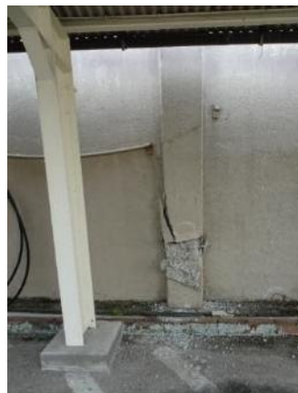
写真 3.2.48-2 柱の圧壊
