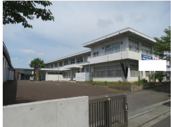
写真 3.4.4-4 建築物外観（UK-5）
