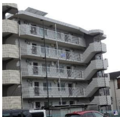
写真 3.2.9-3 周辺にある共同住宅の状況
