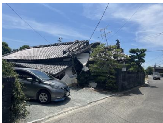
写真 7.2.6a 築年数 80 年以上の木造住宅 の倒壊
