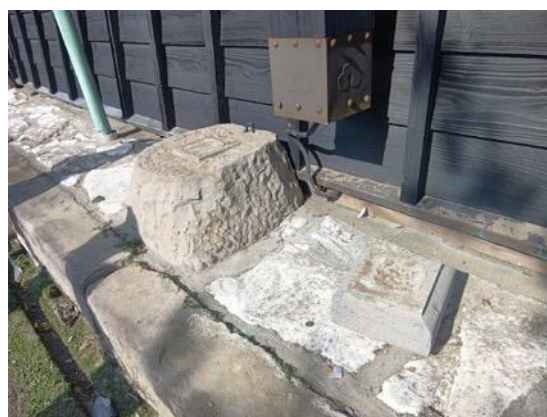
写真 8.2.18 礎石からのずれ（50cm 程）
