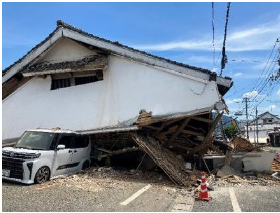
写真 7.2.9 木造住宅の倒壊
