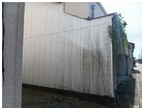
写真 8.2.10 外壁のずれ
