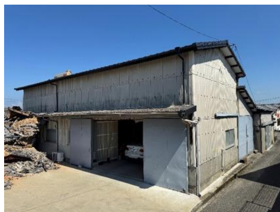
写真 6.2.2 写真 6.2.1 の建物に隣接する建物
