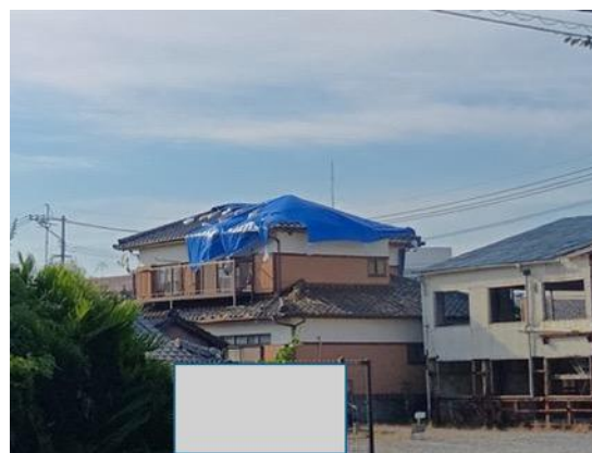
写真 8.2.24 瓦の脱落
