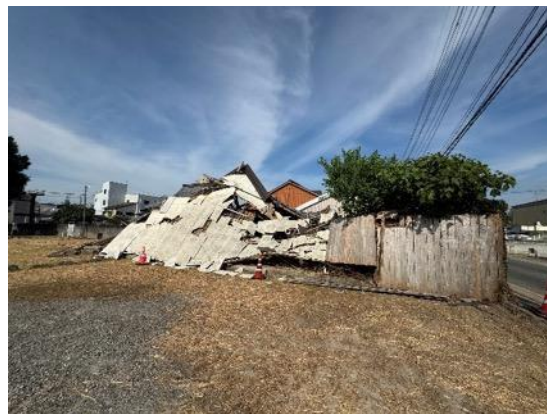
写真 8.2.8 住宅の倒壊
