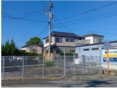
写真 5.2.6 外観上、無被害と 思われる住宅
