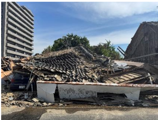
写真 8.2.5 2F 建て住宅の倒壊
