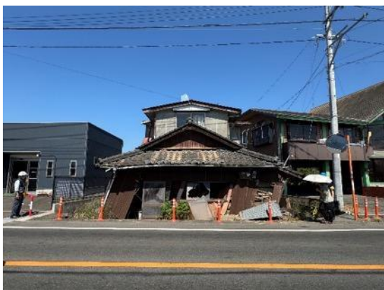
写真 6.2.3a 大きな残留変形のある家屋
