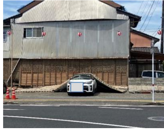
写真 7.2.14 外壁の脱落
