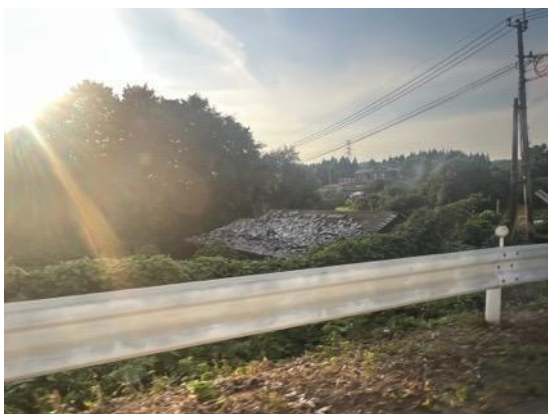
写真 9.2.2 周辺の瓦屋根被害
