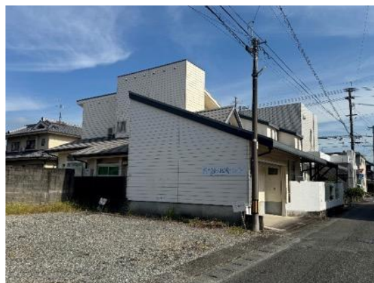
写真 8.2.12 住宅（外観被害なし）
