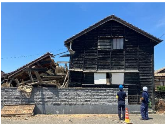
写真 6.2.10 残留変形 81/1000=1/12\text{rad}
