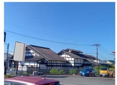
写真 5.2.5b 隣接する建物の瓦屋根被害
