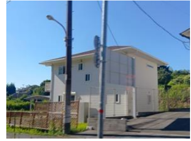
写真 5.2.8 外観上、無被害と 思われる住宅
