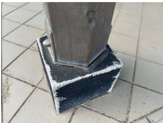
写真 9.2.1c 柱のずれ
