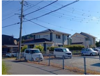
写真 5.2.7 外観上、無被害と 思われる住宅
