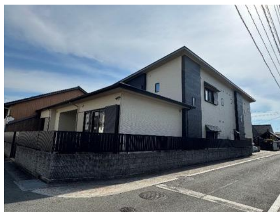
写真 8.2.14 住宅（外観被害なし）
