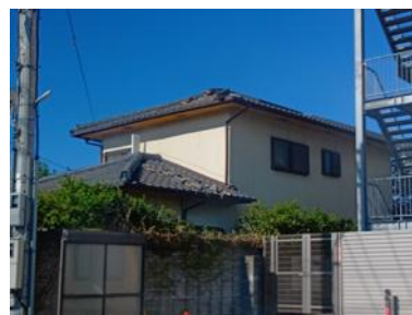
写真 5.2.2 瓦屋根被害
