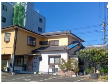
写真 5.2.1 瓦屋根被害
