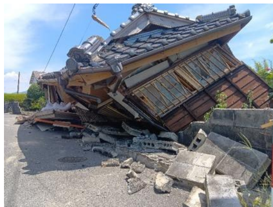
写真 7.2.4 木造住宅の倒壊
