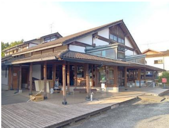
写真 9.2.1a 中規模木造建築物の概観
