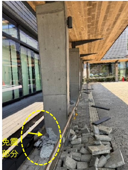
図 4.1.1-13 キャンピアーの柱の破損 図 4.1.1-14 階段手すり部の変形 (B1 階)
