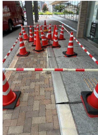
図 4.2.4-3 エキスパンションカバーのずれ
