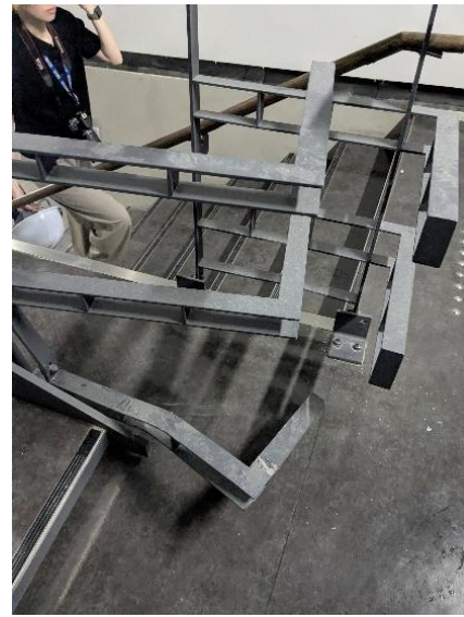
図 4.1.1-13 キャンピアーの柱の破損 図 4.1.1-14 階段手すり部の変形 (B1 階)
