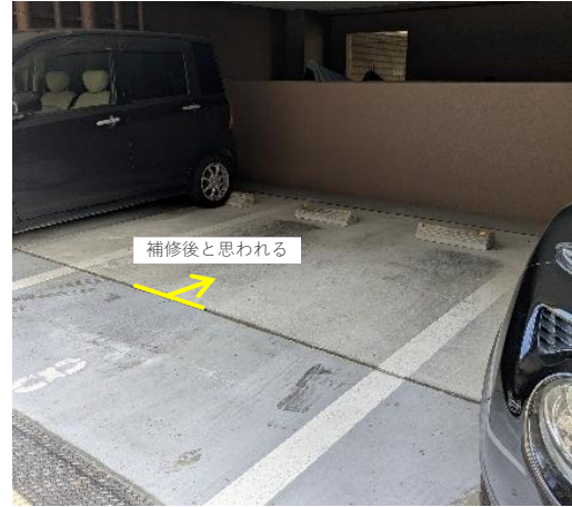
(a) 今回のスラブの状況 ※図 4.3.2-1 と同位置 (b) 補修後と思われる形跡 ※(a)とは別区画 図 4.3.2-2 2016 年の調査と今回の調査における被災状況の比較
