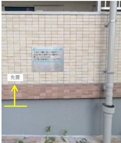
図 4.3.1-1 免震表示（クリアランス 35cm）
