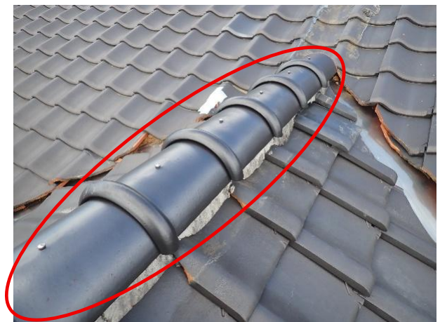
写真 2.3.10 平成 28 年熊本地震後にガイドライン工法で葺き替えた隅棟部の状況（住宅 G）
