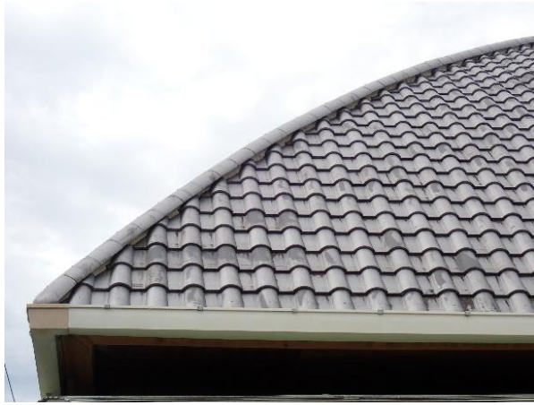
写真 2.1.7 瓦の施工状況
