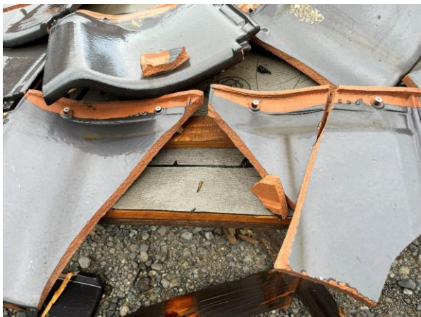
写真 2.4.7 棧瓦のねじ留め状況（寺社 C）
