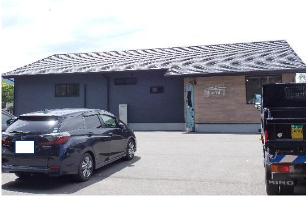
写真 2.3.7 住宅 F の外観
