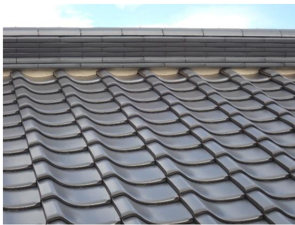
写真 2.3.2 屋根の平部と棟部の状況（住宅 E）
