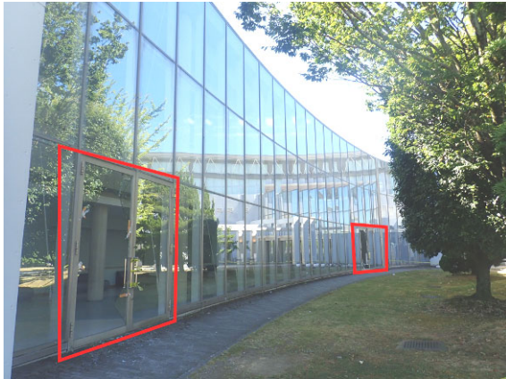
写真 UK-06-a 建物外観
