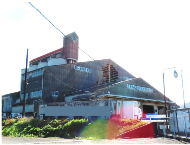
写真 UK-01-a 外観
