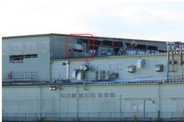
写真 UK-02-a 外観
