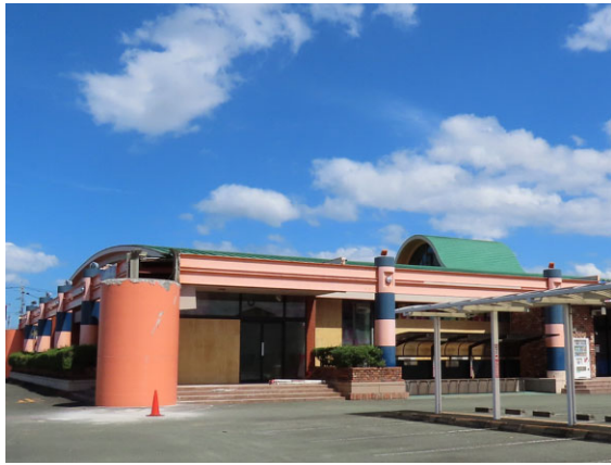
写真 UK-07-a 外観
