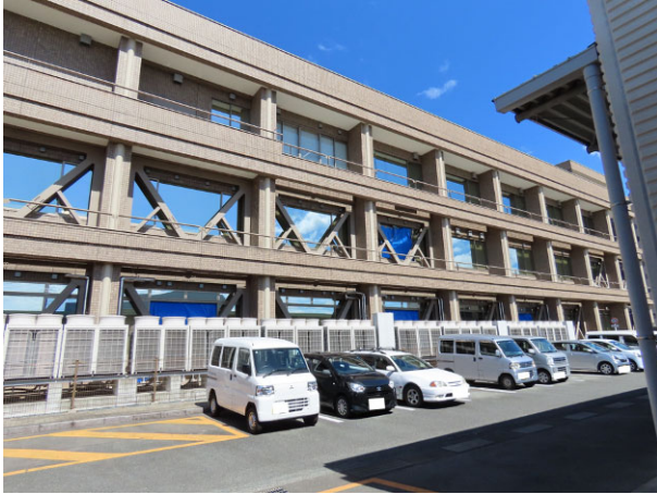
写真 UK-05-a 外観
