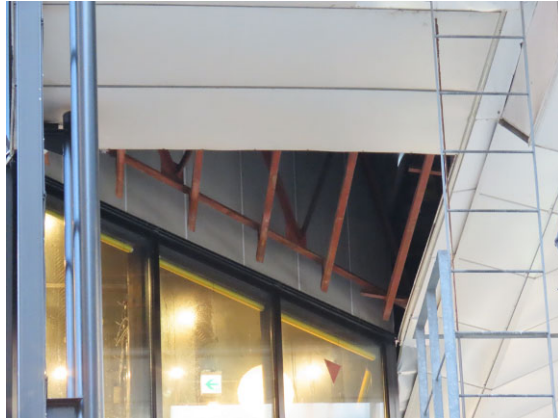
写真 KU-04-b 写真 KU-04-a の被害の別角度からの近接写真
