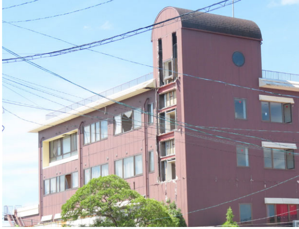
写真 UK-09-a 外観
