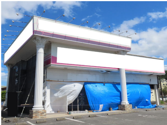
写真 UK-08-a 外観
