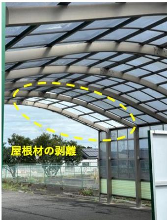
写真 3.5 カーポートの屋根材の剥離状況
