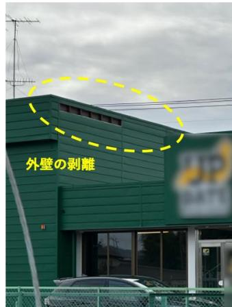
写真 3.6 外壁の剥離状況
