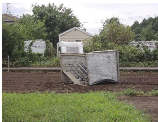
写真 3.8 鋼製物置の飛散状況
