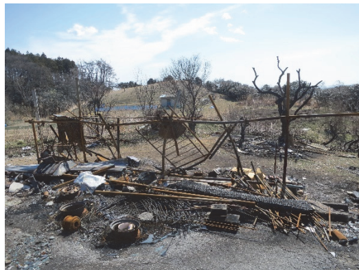
図 8.7.15 簡易な構造物の被害（地点⑭）
