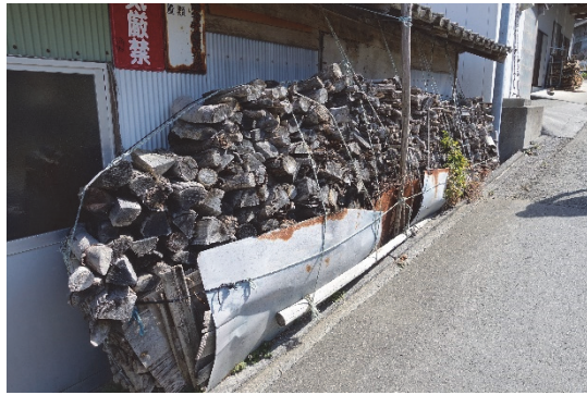
図 8.8.9 建築物周辺の可燃物（綾里田浜地区）
