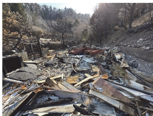
図 8.2.4 建物③の焼損状況
