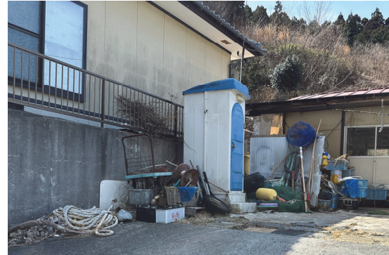
図 8.8.10 建築物周辺の可燃物（綾里田浜地区）
