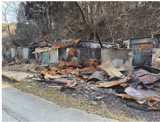
図 8.2.11 建物⑫の焼損状況
