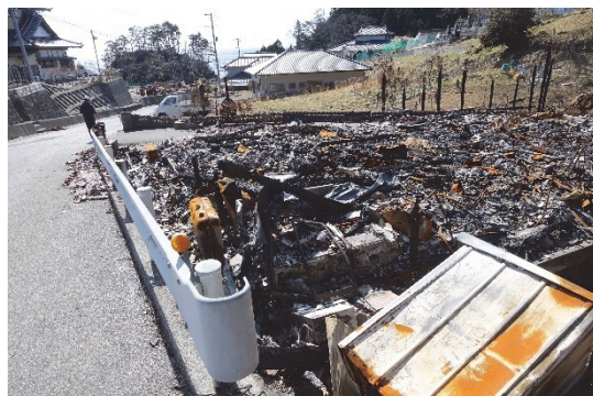
図 8.7.9 地区中央の山林の西側の被害状況 (地点⑧)
