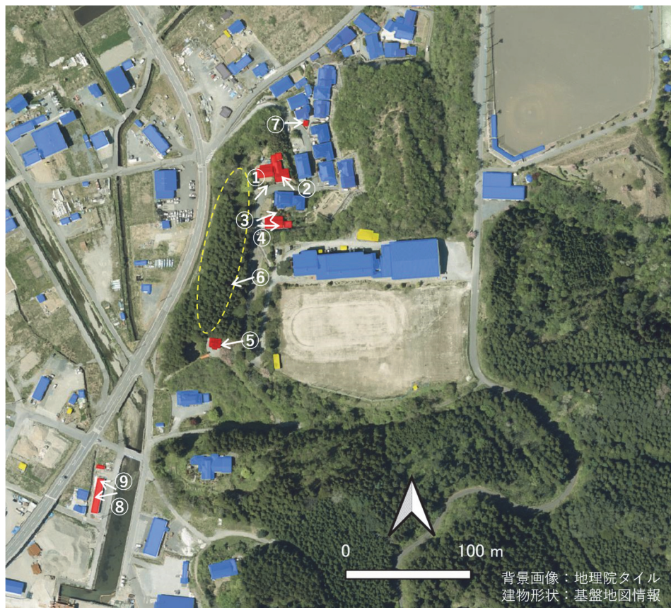
図 8.3.1 黒土田周辺の建築物等の被害状況
