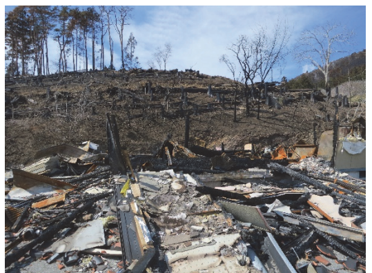
図 8.7.13 地区中央の山林の北側の被害状況 (地点⑫)
