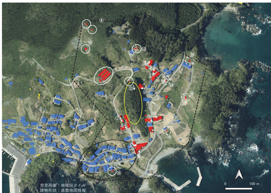
図 8.7.1 外口地区被害状況
