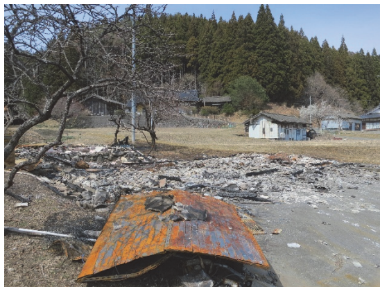
図 8.6.2 被害がまだら状に分布する状況 (図 8.6.1 黄丸部分)
