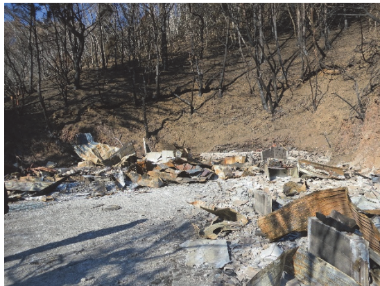
図 8.5.2 山林に近接した位置にある建物の焼損状況（図 8.5.1 青円部分）
