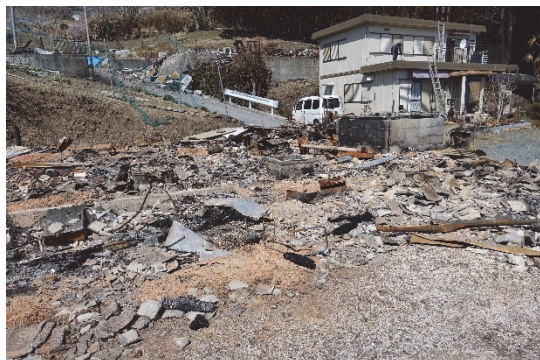
図 8.7.2 地区北側の被害状況（地点①）
