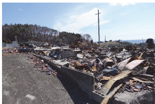
図 8.7.11 地区中央の山林の東側の被害状況 (地点⑩)
