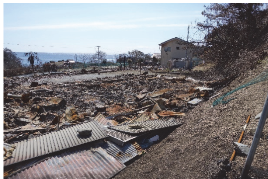
図 8.7.3 地区北側の被害状況（地点②）
