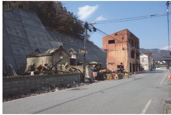
図 8.1.12 火災後の現地の様子（地点⑨）
