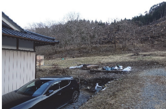
＜物置の焼損状況＞
