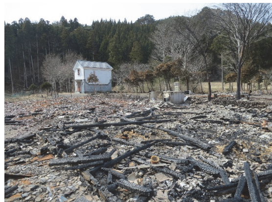
図 8.6.3 被害を受けた建物の焼損状況 (図 8.6.1 白丸部分)
