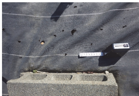
図 8.8.6 図 8.8.5 の詳細（綾里田浜地区の延焼していない宅地）
