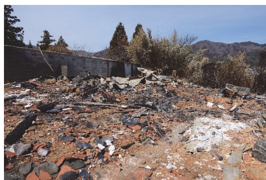
図 8.3.3 建物被害の様子（地点②）
