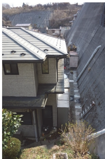
図 8.1.16 火災後の現地の様子（地点⑫）
