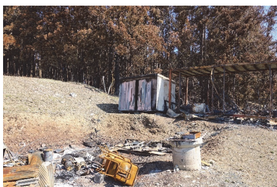
図 8.8.7 簡易な構造物の焼損痕（外口地区）
