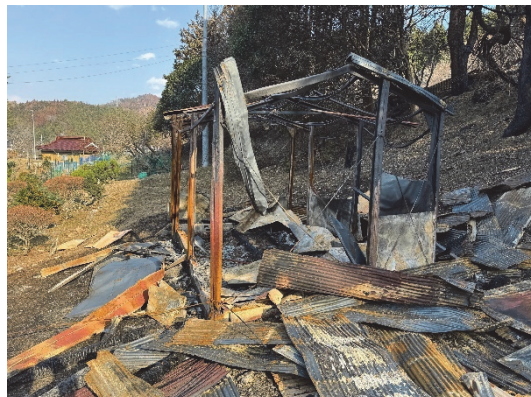
図 8.2.8 建物⑦の焼損状況
