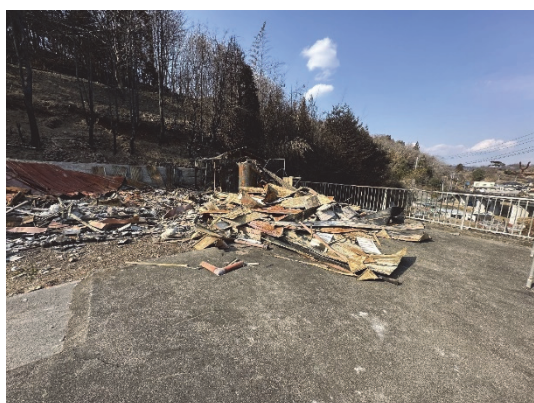
図 8.2.3 建物②の焼損状況
