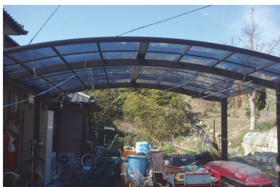
図 8.8.3 カーポートの状況 (外口地区の延焼 していない住宅)
