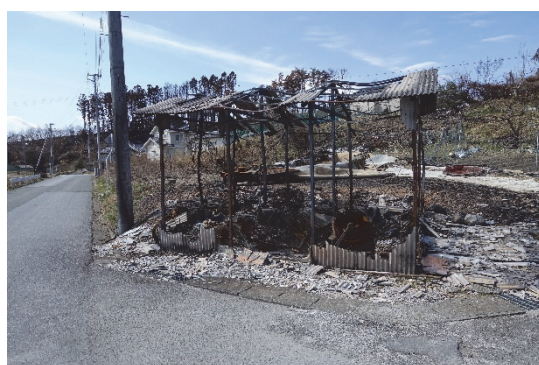
図 8.8.8 簡易な構造物の焼損痕（外口地区）
