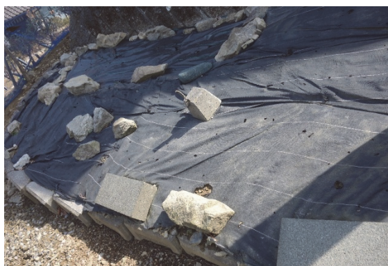
図 8.8.5 防草シートの様子（綾里田浜地区の延焼していない宅地）
