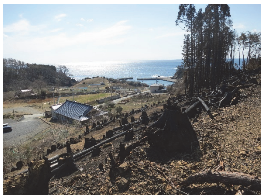
図 8.7.12 地区中央の山林の被害状況 (地点⑪)
