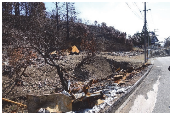
図 8.7.8 地区中央の山林の西側の被害状況 (地点⑦)
