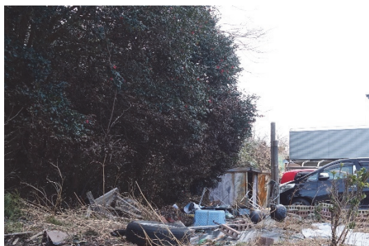
図 8.7.16 簡易な構造物の被害（地点⑮）
