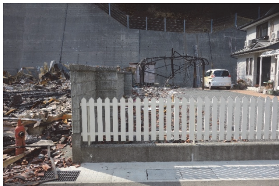
図 8.1.7 火災後の現地の様子（地点⑤）
