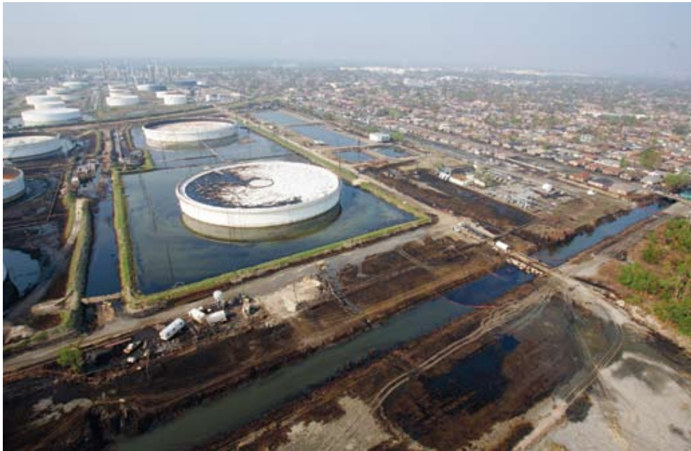
図-2.2 浸水した石油備蓄タンク地
