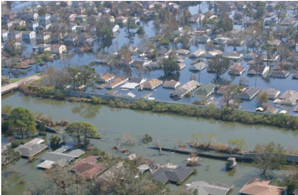
図-5.8 London Avenue Canal の北側での破堤
