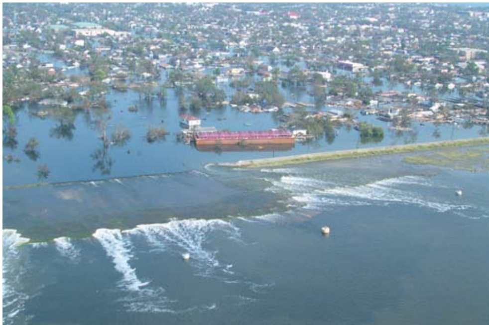
図-5.5 Industrial Canal 東岸の南側の破堤
