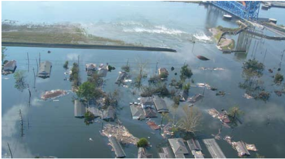
図-5.4 Industrial Canal 東岸の北側の破堤
