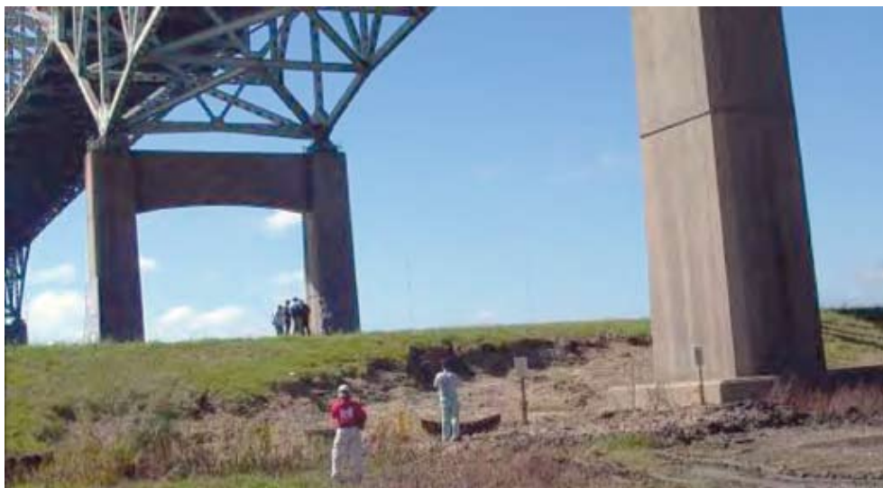
図-7.11 ニューオーリンズ東部のパリスロード橋(Paris Road Bridge)下の堤防
