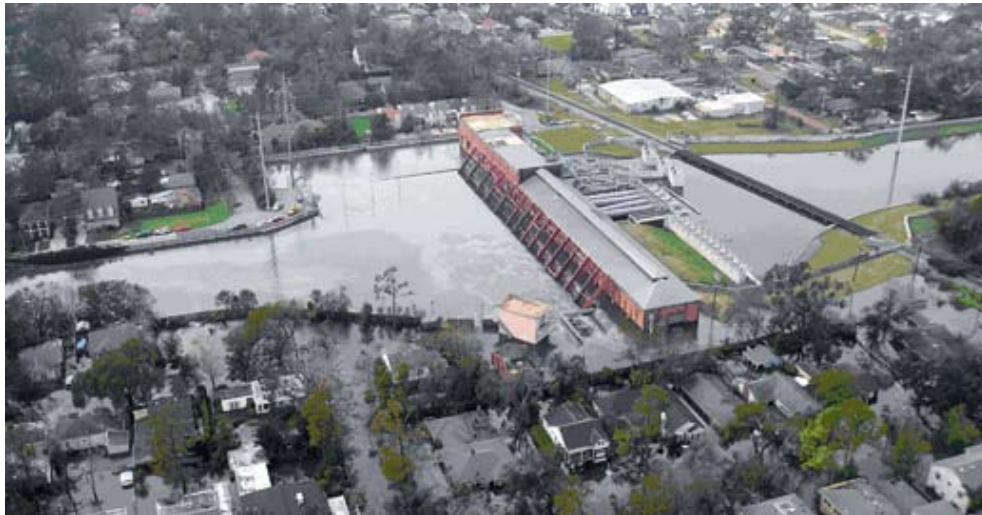
図-5.11 浸水した第 6 ポンプ場
