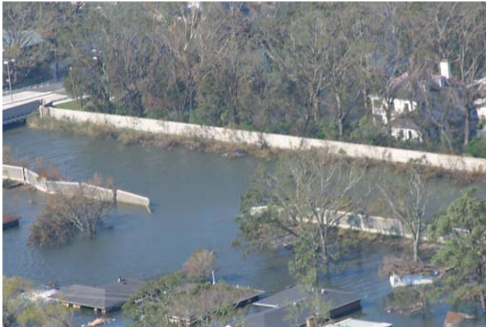
図-5.6 London Avenue Canal の南側での破堤
