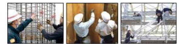
(ロボットの支援が見込まれる職種例(鉄筋工・型枠工・とび工など))
