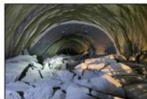
（トンネル内部の覆工崩落例）
