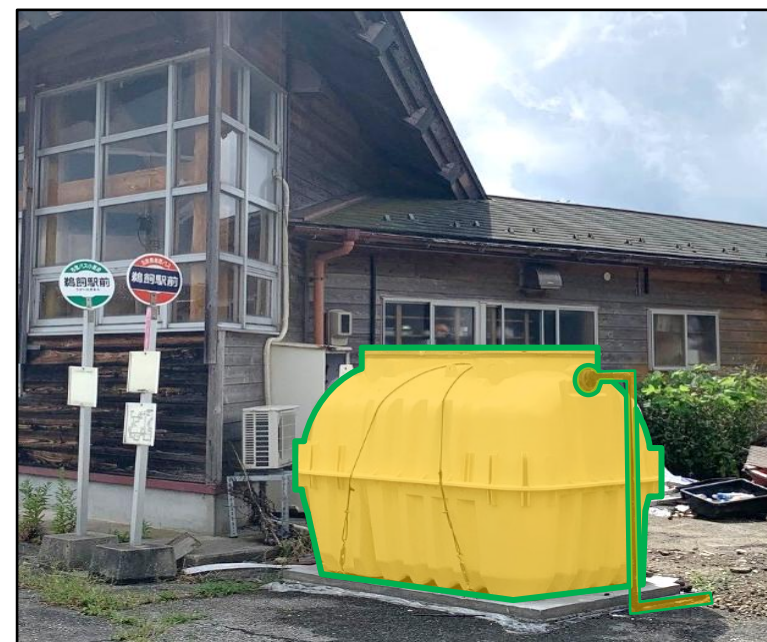
仮設浄化槽の設置 (宝立処理区鶺飼地区)
