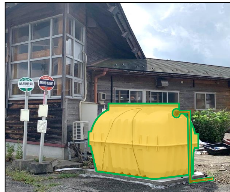
仮設浄化槽の設置 (宝立処理区鵜飼地区)
