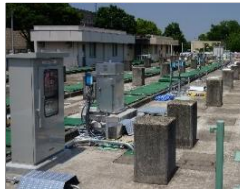
処理能力を向上する技術(2点DO制御方式)
