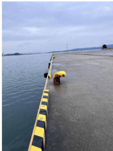
参考資料 写真 4-1 栈橋の法線出入りの状態
