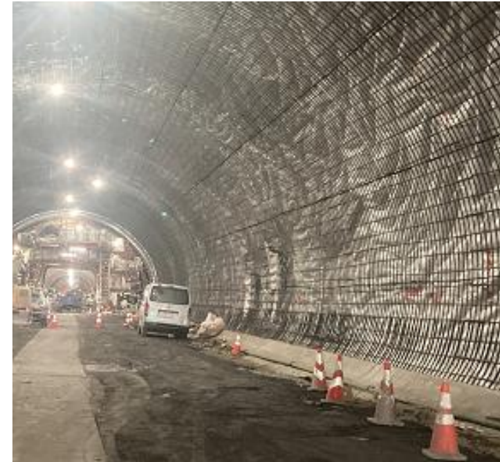
新設トンネルでの覆工崩落対策の例
