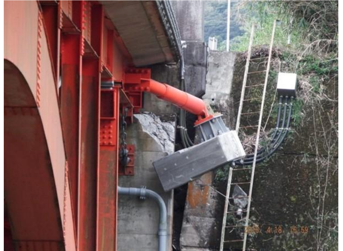
ダンパー取付部の損傷
