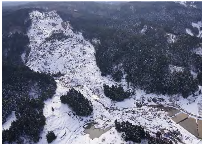
市ノ瀬町の地すべり・河道閉塞 (1月14日撮影)
