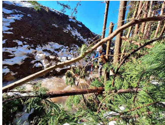
河道閉塞の通水状況 (市ノ瀬地区、1月11日撮影)
