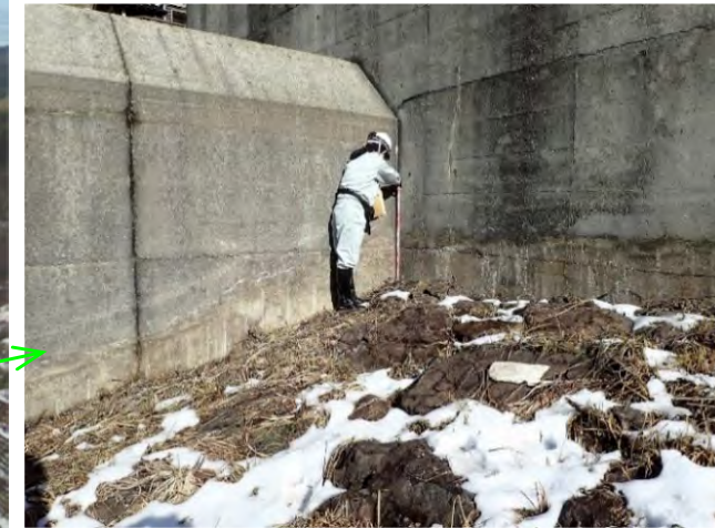
ダム堤体の沈下 （洪水吐きコンクリートとの接合部での状況）
