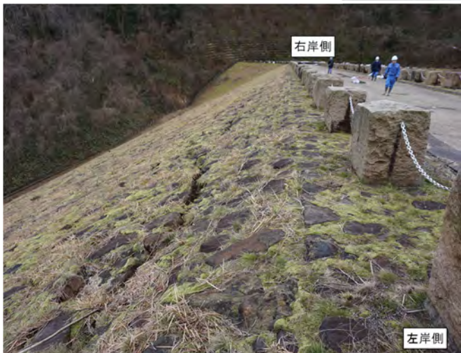
ダム下流面リップラップ材の目開き （背面調査により堤体に異常がないことを確認）
