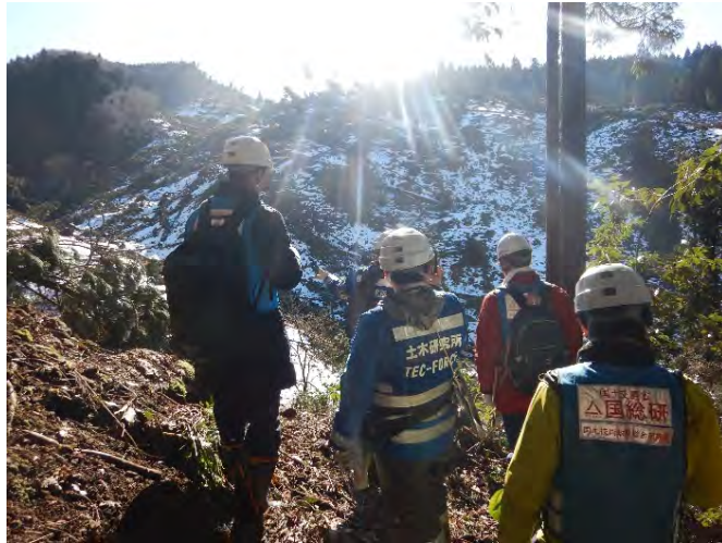
河道閉塞部の状況 (市ノ瀬地区、1月11日撮影)
