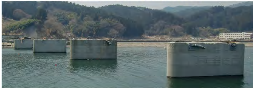
津波の影響に対する橋の破壊形態 (2011年東北地方太平洋沖地震)
