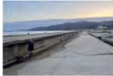
【マリンタウン岸壁(水深-7.5m)】 ・背後段差、法線ズレ
