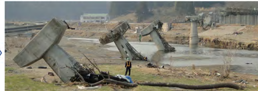
津波の影響に対する橋の破壊形態 (2011年東北地方太平洋沖地震)
