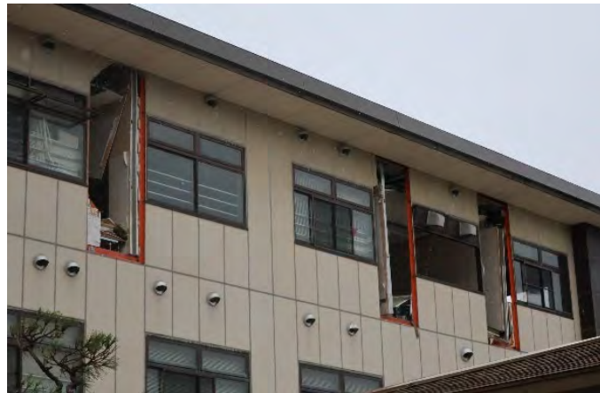
外壁の脱落被害
