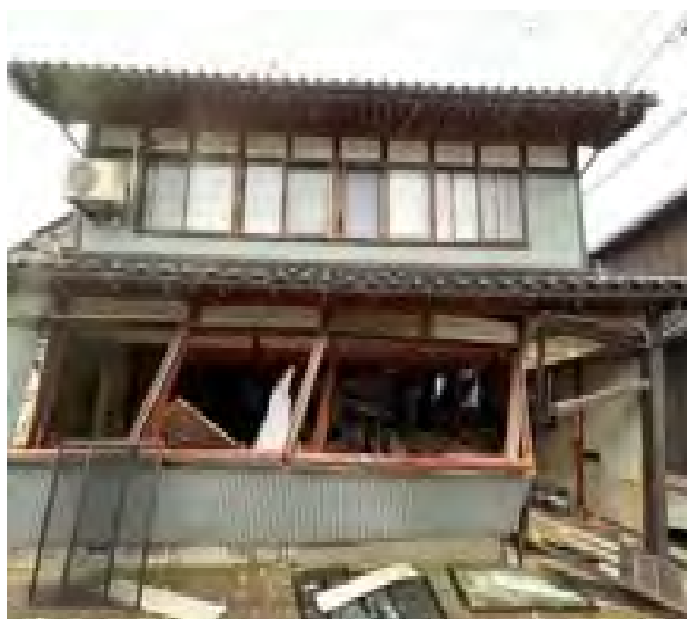
安全限界変形を超える大きな残留変形が残る木造建築物
