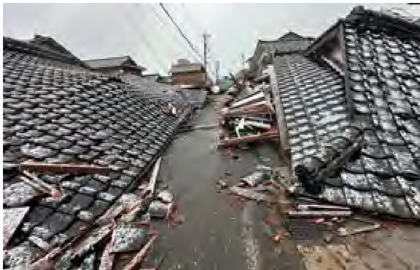
築年数の古い木造建築物の倒壊と道路の閉塞
