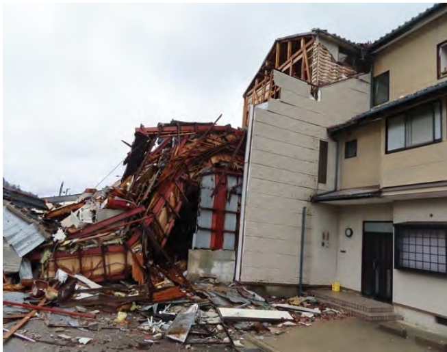
2階・3階が崩壊した鉄骨造建築物
