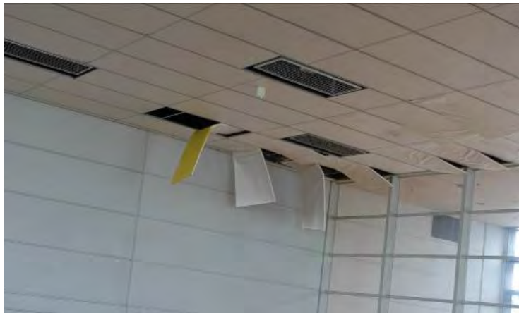
大規模空間の天井の脱落被害
