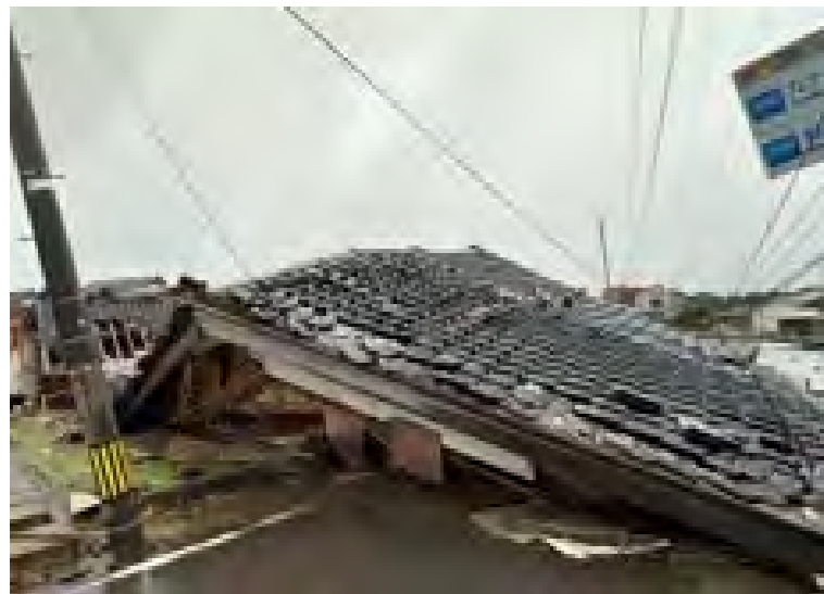
築年数の古い木造建築物の倒壊と道路の閉塞
