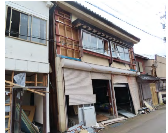
大きな残留変形した鉄骨造建築物
