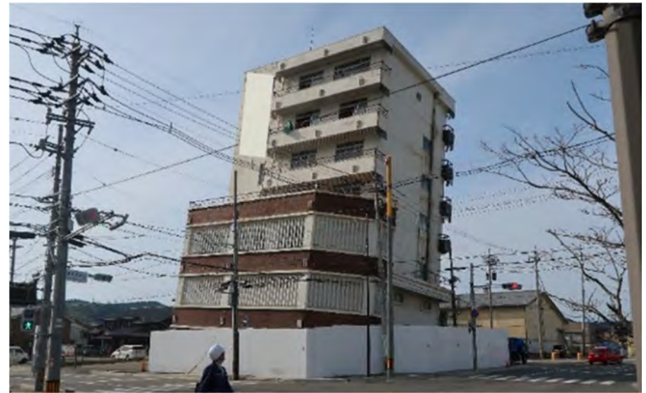
傾斜した鉄筋コンクリート造建築物
