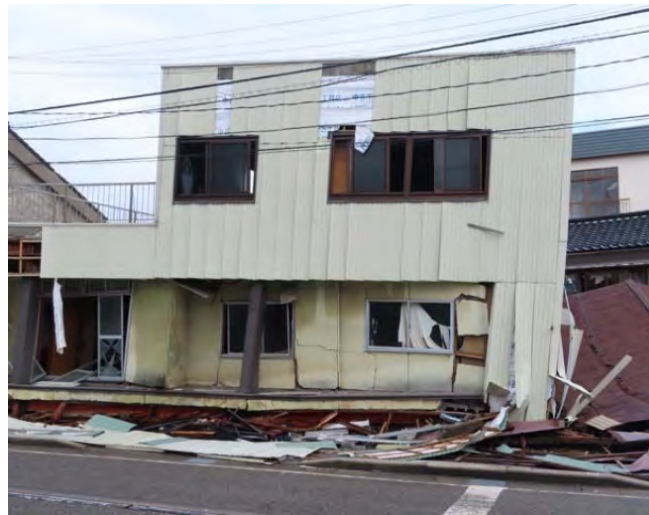
1階が層崩壊した鉄骨造建築物
