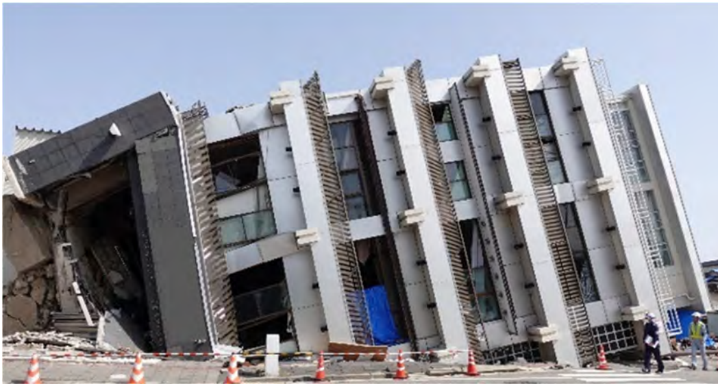
転倒した鉄筋コンクリート造建築物
