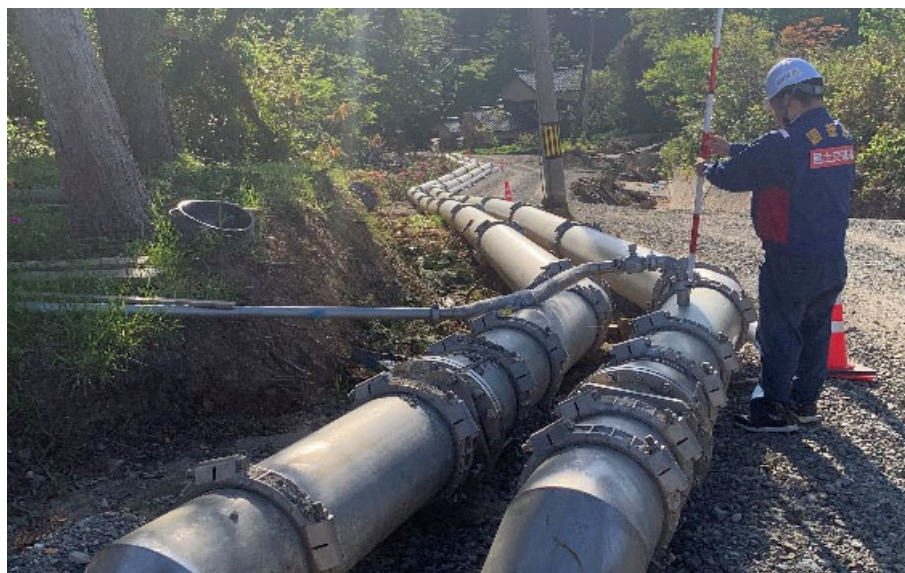
露出配管(送水管・配水管、下水管)の 応急復旧状況(輪島市)
