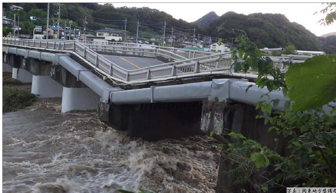
橋脚が沈下した国道20号法雲寺橋（山梨県大月市：10月13日）
