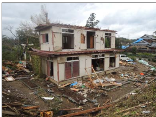
住宅の屋根や開口部等の損壊 (10月15日)
