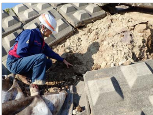
吉田川堤体状況の調査 (10月16日)
