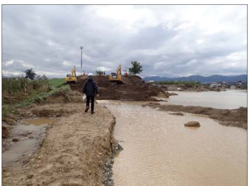
千曲川水系千曲川の堤防決壊状況 (10月15日)
