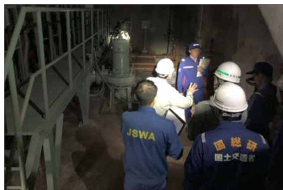
本宮市汚水ポンプ場の被害状況確認 (10月24日)
