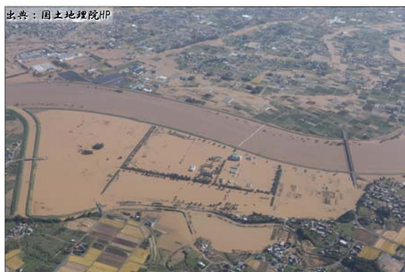
阿武隈川流域下水道県北浄化センターの水没状況 (10月13日)
