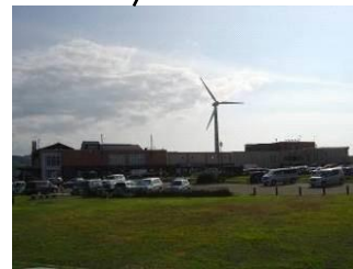
道の駅「能生(マリンドーム能生)」
