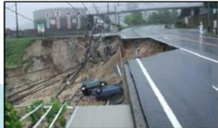
① 国道201号 福岡県飯塚市 【盛土法面の崩壊】
