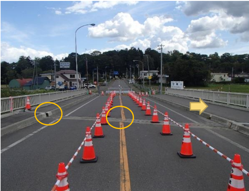
斜角を有する橋梁の回転移動
