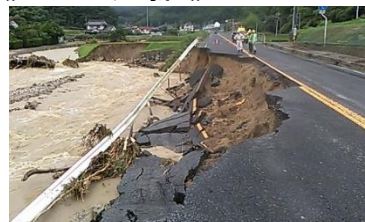
国道2号(広島県竹原市)
