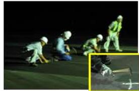
巡回目視による舗装表面の点検 打音による舗装内部の点検
