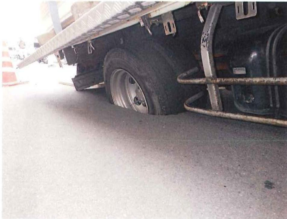
S市: 150mm(取付管)、S47、接合不良、長さ0.5×幅0.4×深さ0.5m
