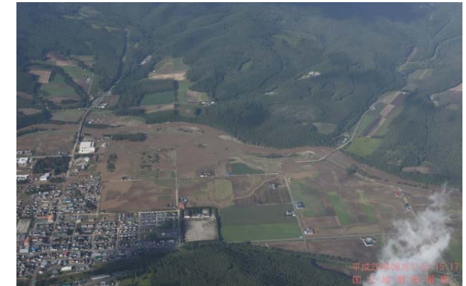
南富良野町(空知川)の氾濫
