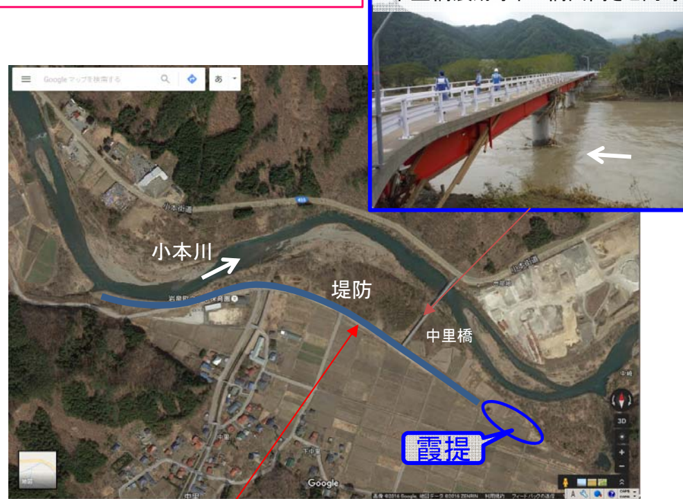
中里地区(中里橋周辺)被災状況
