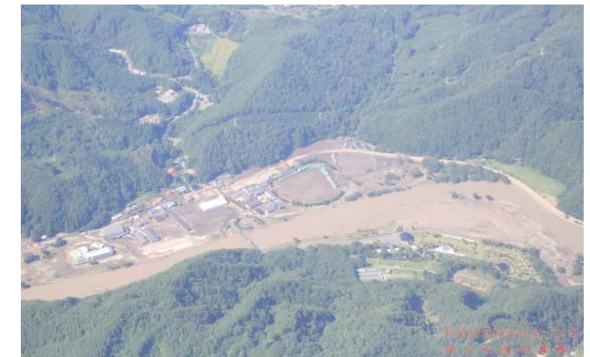
小本川乙茂地区の氾濫
