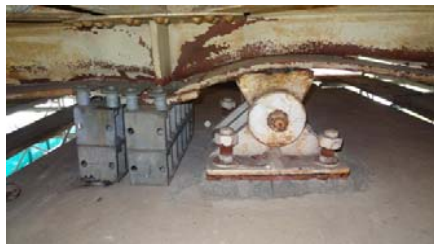
支承部の損傷及び橋脚の傾斜 (九州自動車道・木山川橋)
