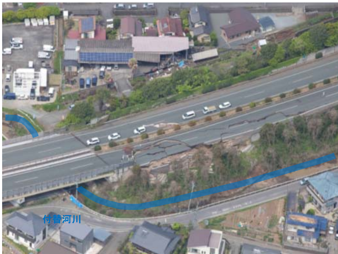
九州自動車道の盛土崩壊全景
