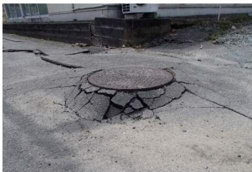
写真-1 マンホールの浮き上がり及び周辺地盤の沈下
