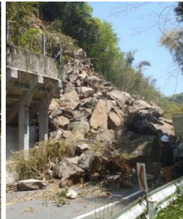
国道445号 熊本県上益城郡御船町滝尾
