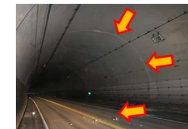
覆工コンクリートのひび割れ (南阿蘇トンネル)
