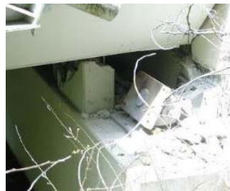
支承部の損傷に伴う桁端部の浮き上がり (県道熊本高森線・桑鶴大橋)
