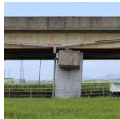
支承部の損傷及び橋脚の傾斜 (九州自動車道・木山川橋)
