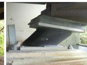
写真-3 パラペット・ゴム 支承の破壊(俵山大橋 A2橋台)
