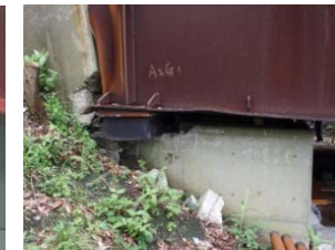
写真-3 パラペット・ゴム 支承の破壊(俵山大橋 A2橋台)
