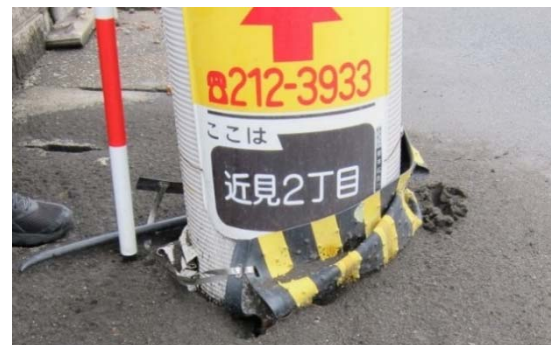
写真-3 液状化による電柱の沈下
