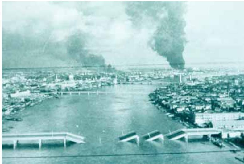
写真。信濃川にかかる昭和大橋の落橋。(写真: 東京大学工学部梅村・同地震研究所大澤研究室蔵)
