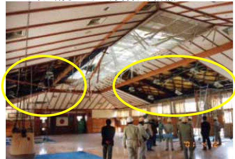
写真。鉄骨屋根からの石膏ボード張りの天井材の落下:B体育館。(国土交通省住宅局建築指導課提供)
