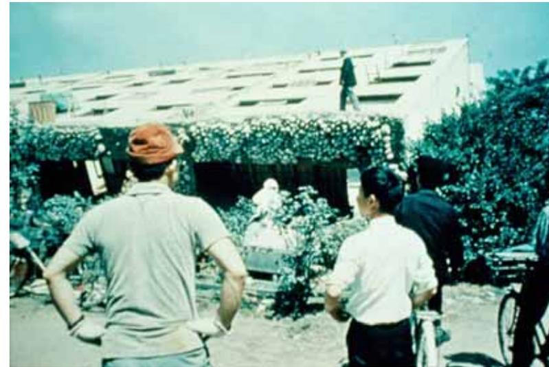
写真。液状化で転倒した川岸町アパート。(写真: 東京大学工学部梅村・同地震研究所大澤研究室蔵)
