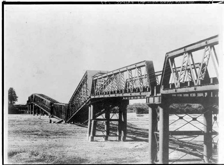
写真。落橋した長良川鉄橋。
