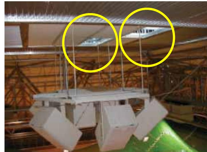
写真。鉄骨屋根から軽量の天井および金具が落下:C体育館。(国土交通省住宅局建築指導課提供)
