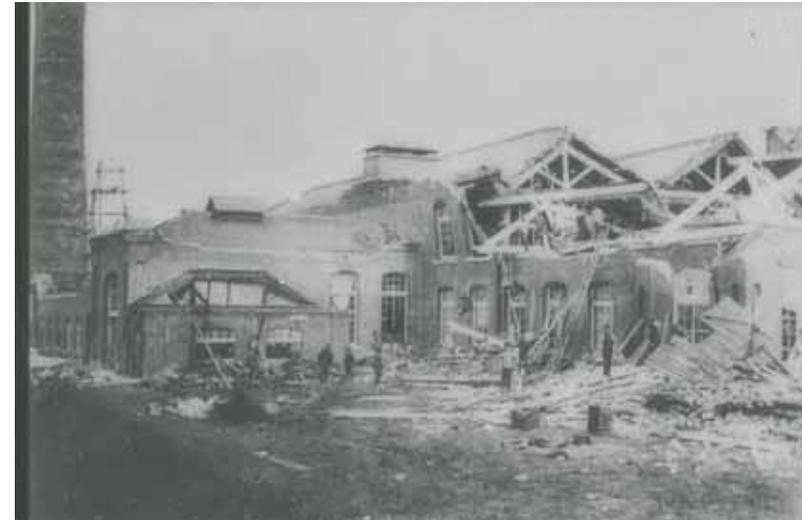
写真。名古屋市内のレンガ造建物の被害状況:明治時代の近代化産業となる紡織業に打撃を与えたとされ、明治政府による地震学・耐震工学の推進につながったといわれている。
