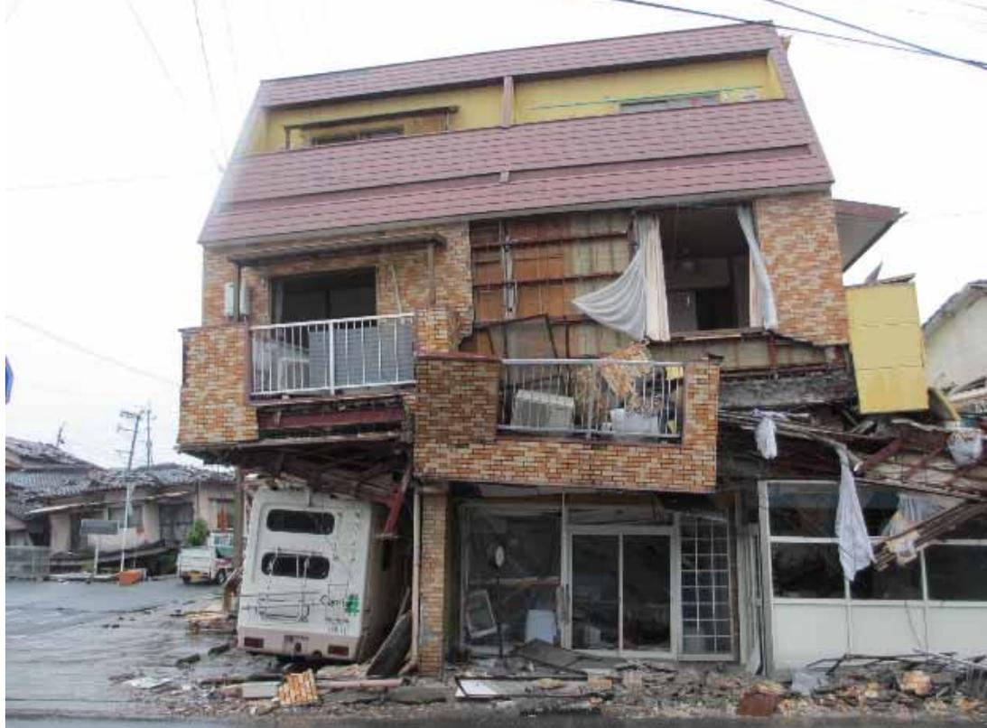
2階が完全に層崩壊している
