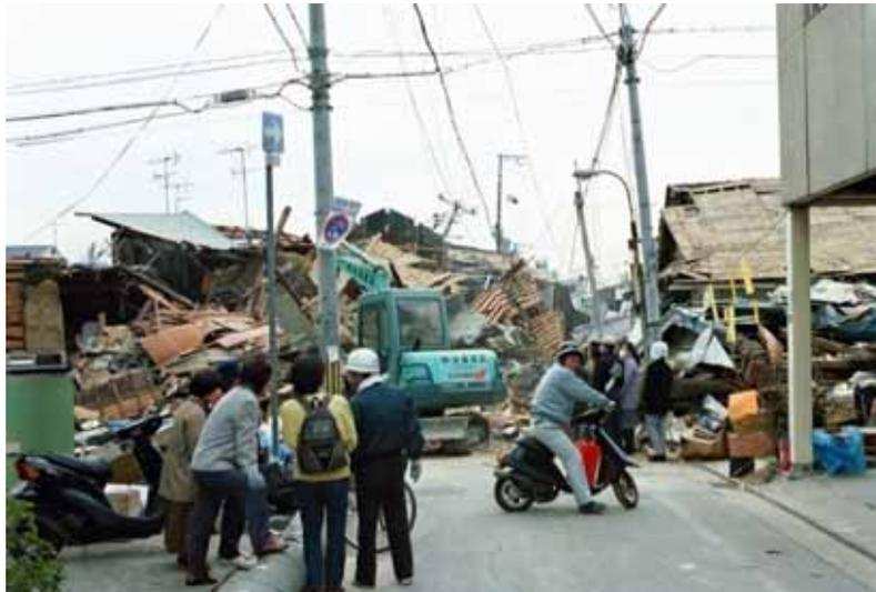
写真 木質系住宅の崩壊:神戸市東灘区.
