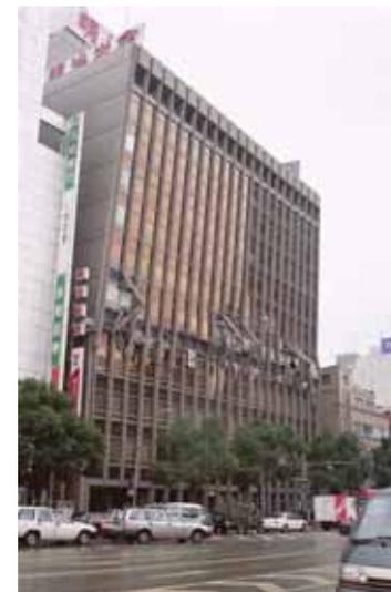
写真 中間層に発生した層崩壊.
