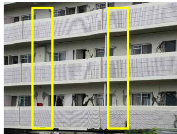
Photo 共同住宅 AG(熊本市東区:1993年建設):廊下側非構造壁の損壊. (2016/07/08撮影)
