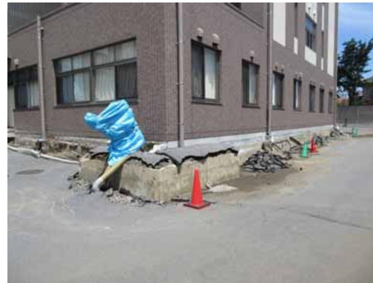
写真. 液状化発生により建物周りの地盤沈下が認められたM病院棟.
