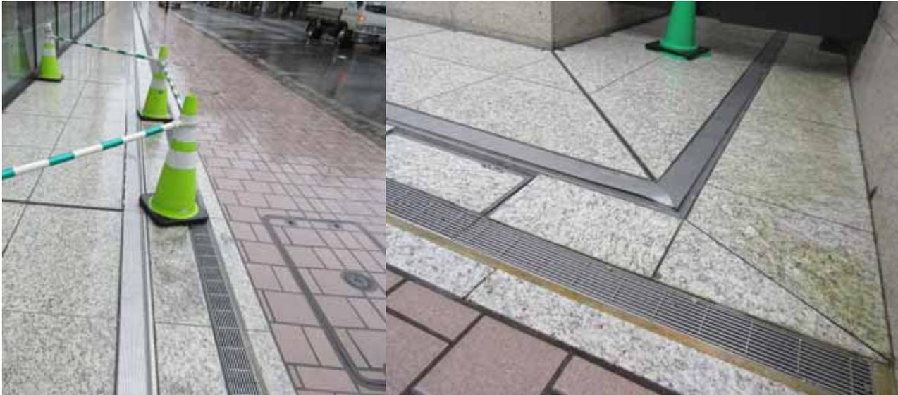
Photo 免震クリアランス: 変形に対する設計は難しい、特にコーナー部.
