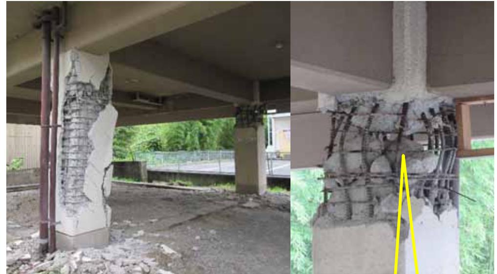
Photo 共同住宅 M (熊本市西区:建設時期不明):柱せん断補強筋より81年以降と推測される。(2016/06/21撮影)
