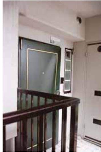
写真 比較的新しい中層マンションに生じた被害:左 隣接棟への渡り廊下部;右 玄関ドアに生じたひずみ.
