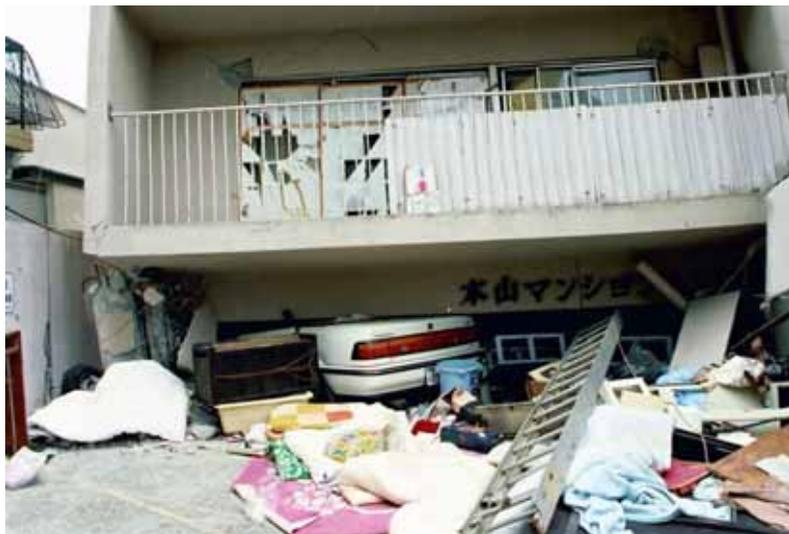
写真 1階が駐車場として使われているR/C造共同住宅の層崩壊.
